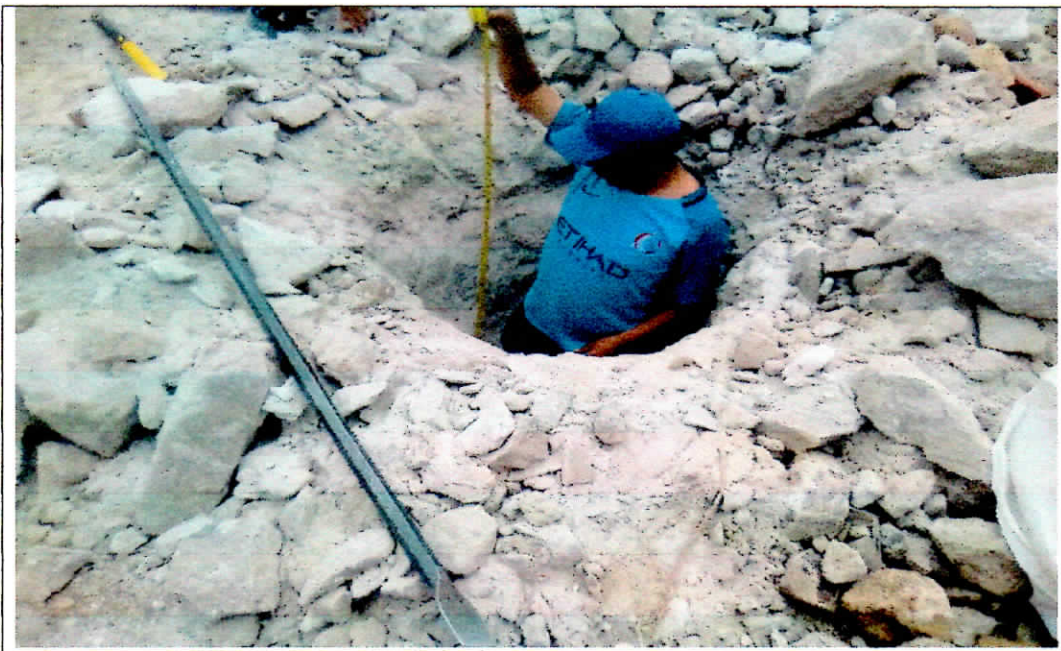
Foto 02: EXCAVACION DE CALICATA EN LA VIVIENDA PROYECTADA PARA LA EDIFICACION (FECHA: 29/12/2020)
