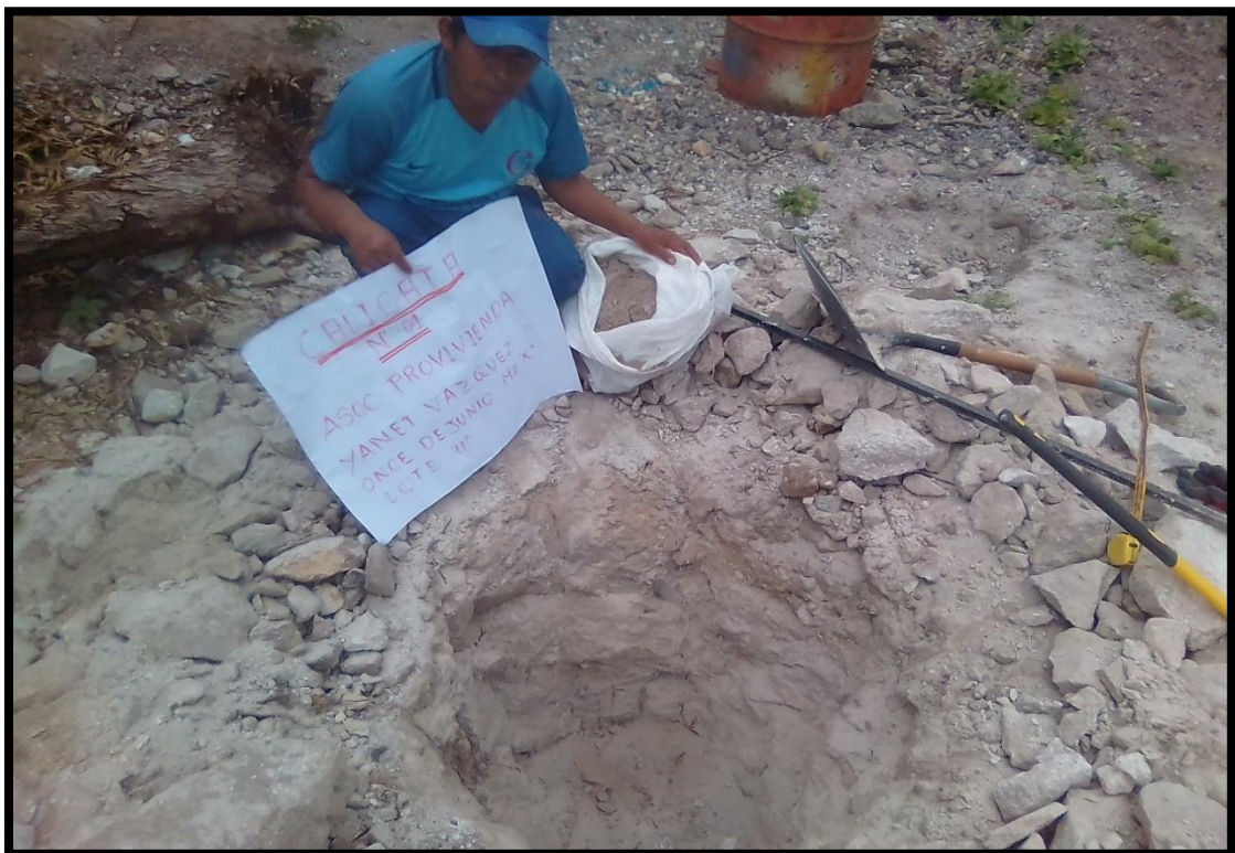
Fotografía 4. Extracción de muestras de suelo de la calicata C1.
