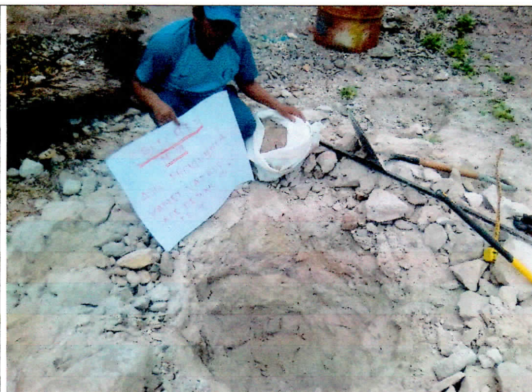
Foto 06: EXCAVACION DE CALICATA EN LA VIVIENDA PROYECTADA PARA LA EDIFICACION (FECHA: 29/12/2020)
