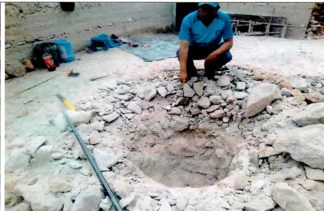
Foto 05: EXCAVACION DE CALICATA EN LA VIVIENDA PROYECTADA PARA LA EDIFICACION (FECHA: 29/12/2020)
