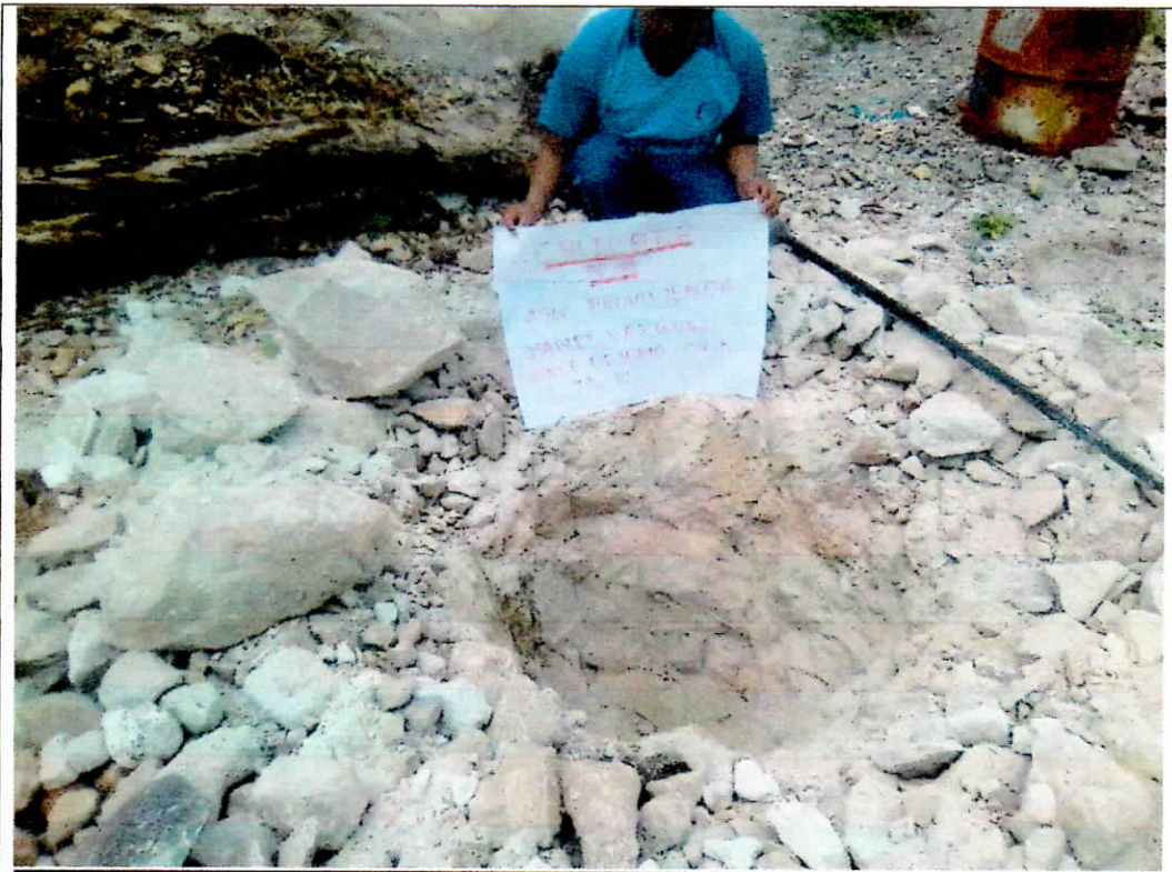
Foto 03: CALICATA N° 01 EN LA VIVIENDA PROYECTADA PARA LA EDIFICACION (FECHA: 29/12/2020)
