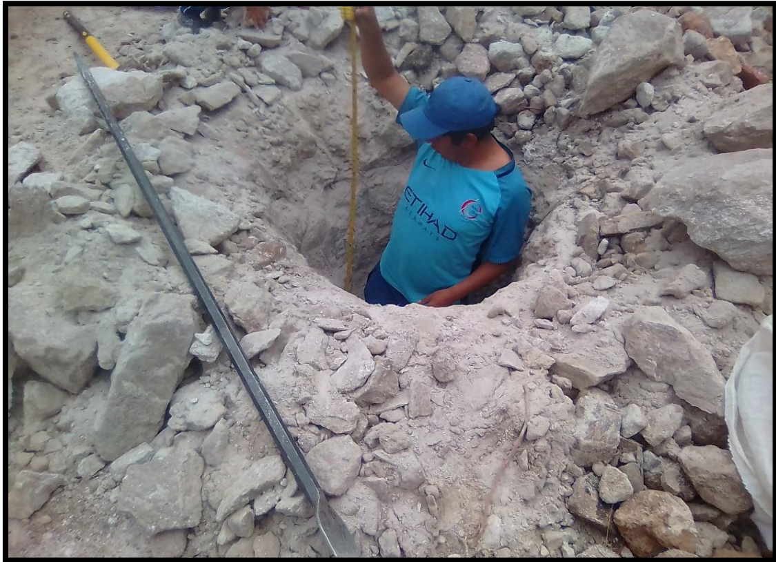
Fotografía 1. Excavación de calicata en la vivienda proyectada para la edificación.
