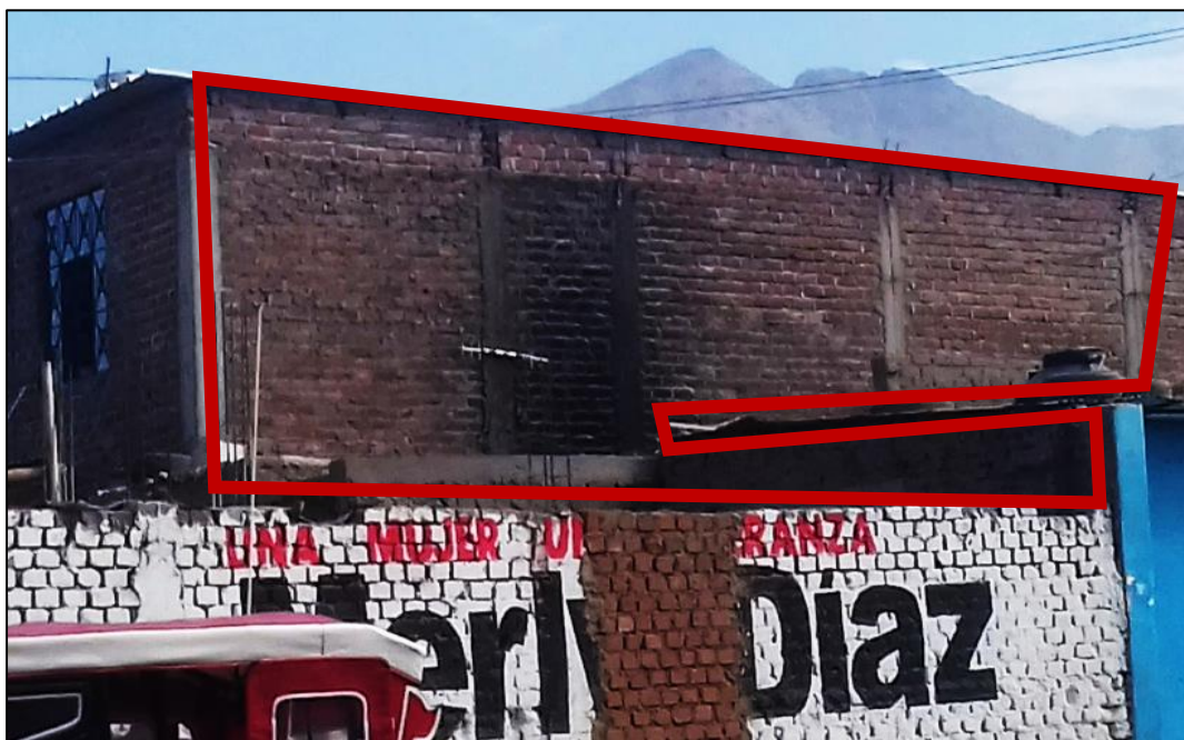
Centro de rehabilitación en la Esperanza (gotitas de fe).
