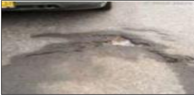
FIGURA 23: Abultamiento y Hundimientos, Alto
