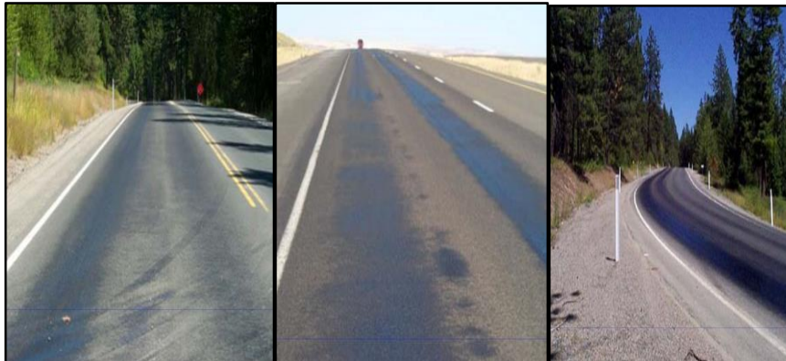
FIGURA 07: Exudación, Nivel de severidad Bajo, Medio, Alto.
