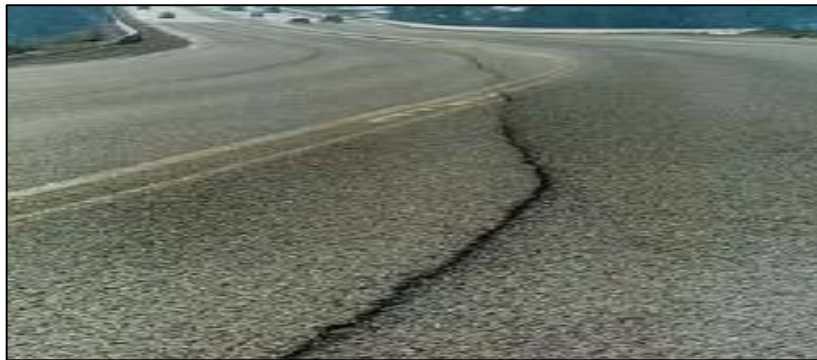
FIGURA 16: Grietas Longitudinales y Transversales Fuente: Maestría en vías terrestres, módulo III
