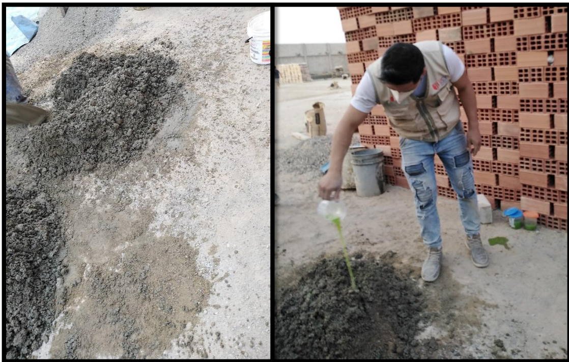
Figura 55: Preparación de la mezcla con mucílago de Nopal.
