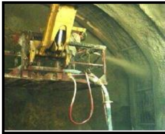
Figura 2: Aplicación de un concreto especial (concreto lanzado).
