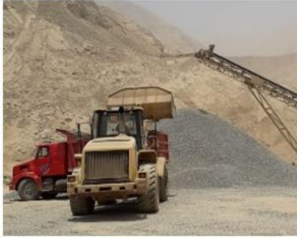
Figura 22: Extracción del Agregado Grueso Cantera Gloria
