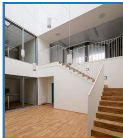
En las escaleras se utiliza la madera como acabado, las barandas son de acero inoxidable.
