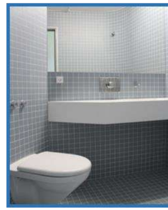
Para las paredes y pisos de los baños utilizaron la cerámica ya que son resistentes y dan un buen acabado.
