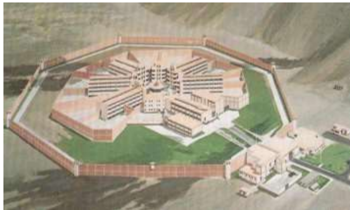
Figura 9: Vista aérea del penal Miguel Castro Castro - Lima.
