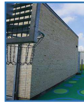
En algunas paredes utilizaron el ladrillo de color con el fin de no tarrajar y porque tiene un buen acabado.
