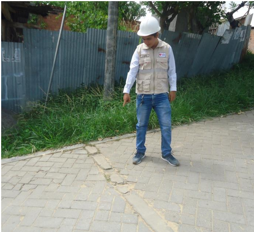
Dislocamiento de adoquines por exceso de carga o movimientos sísmicos
