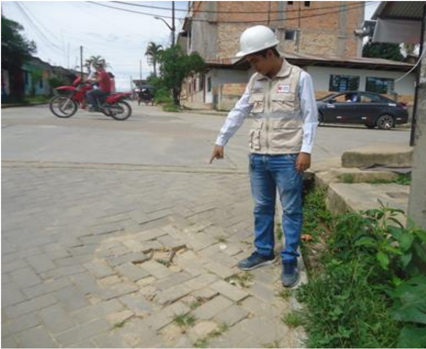
Dislocamiento de adoquines por exceso de carga o movimientos sísmicos
