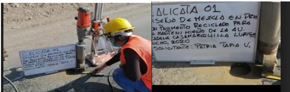
Figura 17: Extracción de calicata 1 y de medida de espesor-Fuente propia
