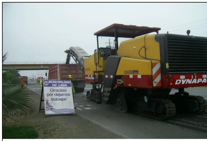
Figura 10: Lugar de fresado mecánico Av. Javier Prado. Toma realizada por el autor
