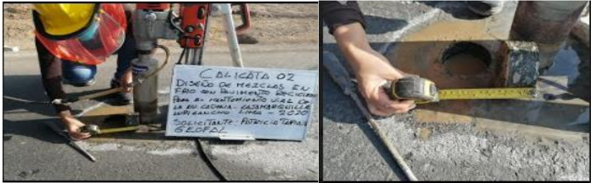
Figura 18: Extracción de calicata 2 y de medida de espesor-Fuente propia
