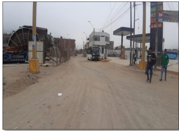
Figura N° 8: Via de la Avenida Cadenas
