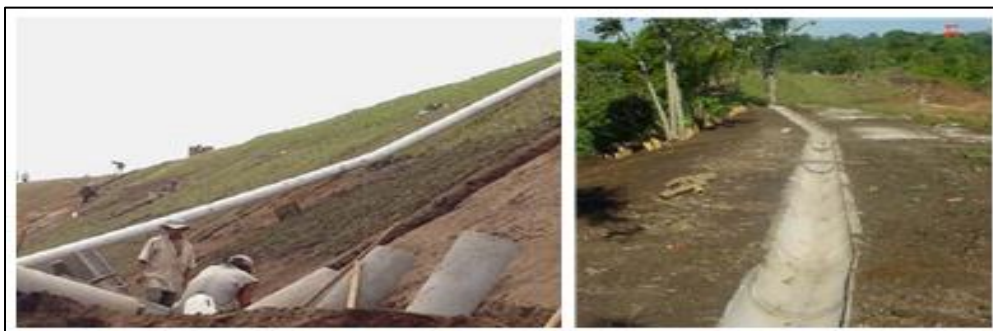
Figura 5. Construcción de cunetas en bermas y en la corona de un talud, utilizando elementos prefabricados de concreto.
