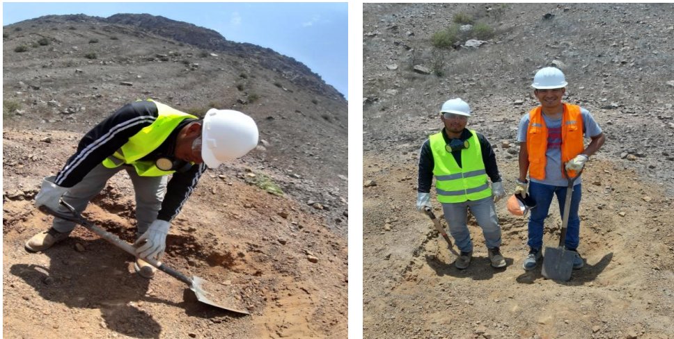
Figura 31. Elaboración de calicatas para determinar el nivel freático. Fuente: Elaboración propia.
