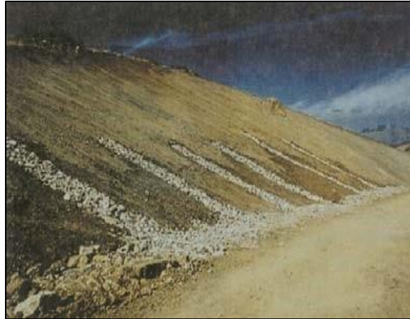
Figura 9. Ejemplo de un sistema de drenes transversales.
