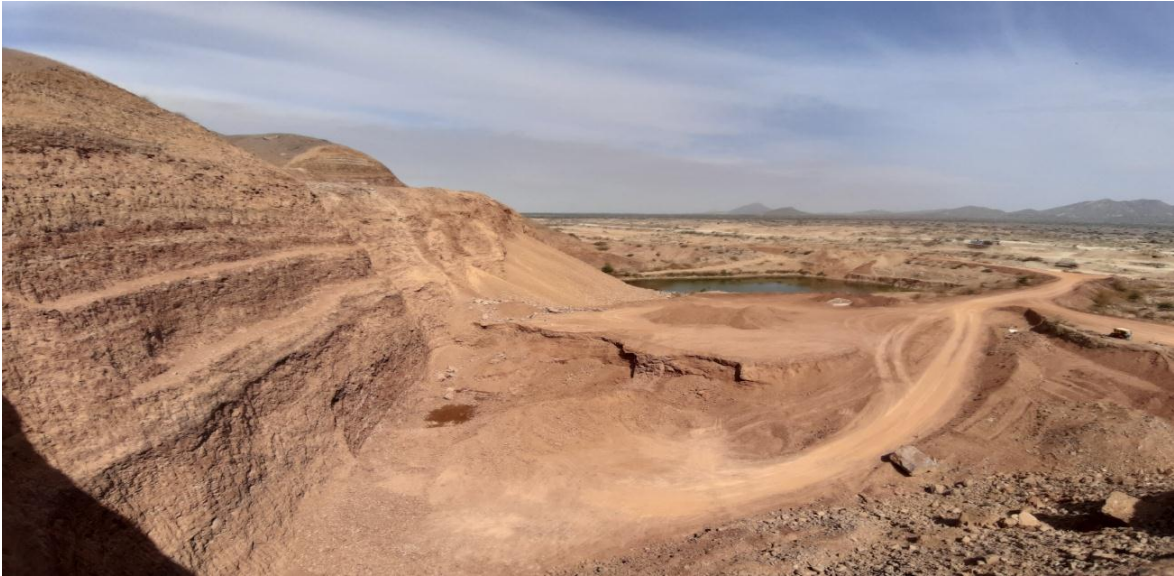
Figura 25. Distancia de los estratos expuesta en la cara libre del talud de corte.
