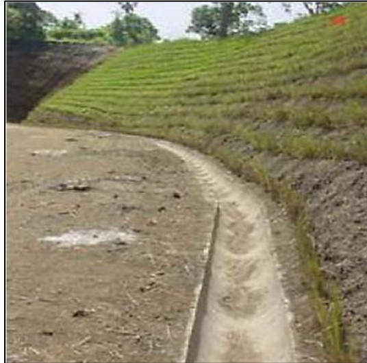
Figura 6. Contracuneta en base de talud, Las Colinas, La Libertad.
