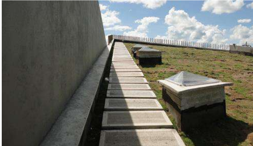
Figura 16. Techo inclinado del Biblioparque David Sánchez Juliao.
