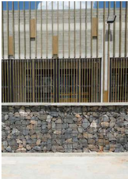
Figura 15. Materiales constructivos del Biblioparque David Sánchez Juliao. Recuperado de: https://www.archdaily.pe/pe/755568/biblioparque-david-sanchez-juliao-plus-a662-arquitectos/54405857c07a802a690003a2-biblioparque-david-sanchez-juliao-plus-a662-arquitectos-foto
