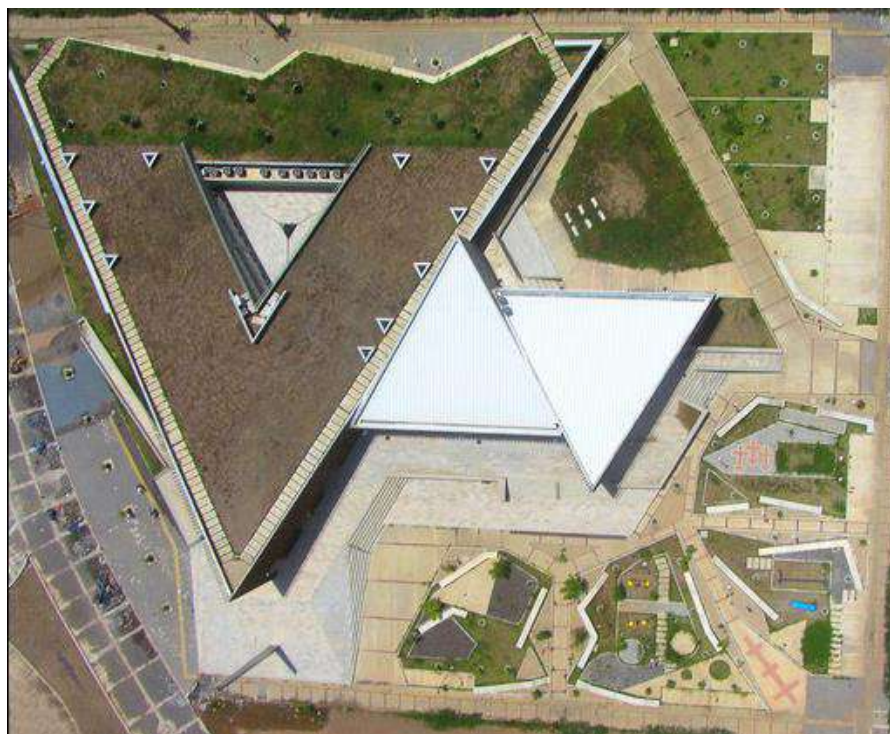
Figura 13. Vista techo del Biblioparque David Sánchez Juliao.
