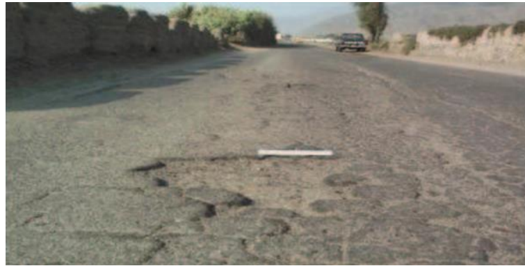
Figura 21: Gravedad 3: diámetro > 0.5 m
