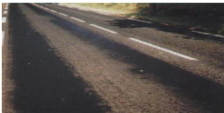
Figura 25: Exudación – Gravedad 3: Continua con superficie viscosa
