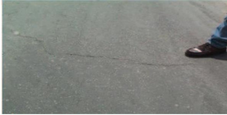
Figura 22: Fisuras transversales
