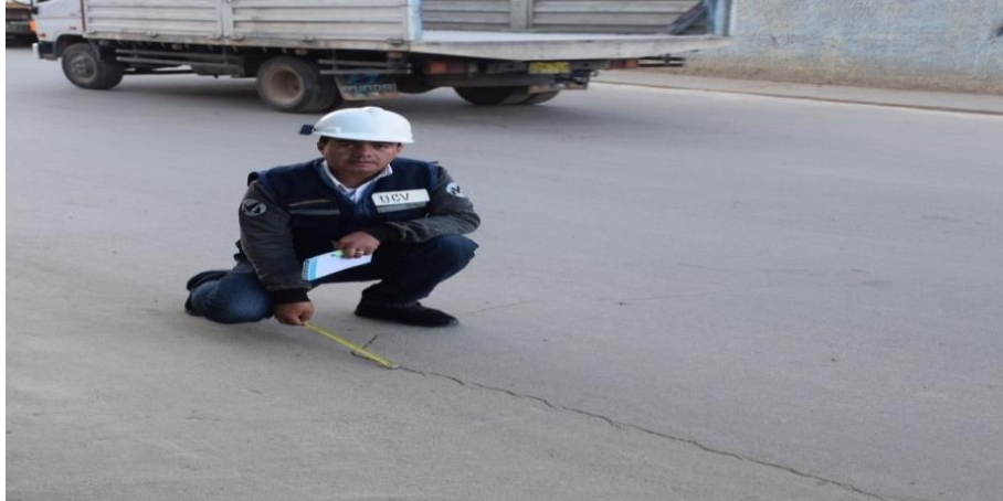
Evaluación de una grieta longitudinal
