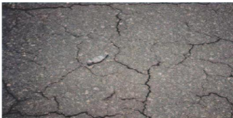
Figura 04: Gravedad 2: Malla mediana (entre 0.30 y 0.5)
