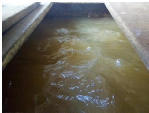
Figura 35: Nivel de salmuera en la parte final del corredor (nivel de salmuera no adecuada).
