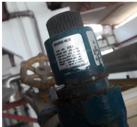
Figura 29: Válvula solenoide HS7.
