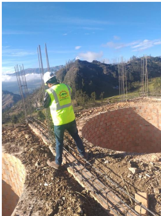
Figura 12. Vista fotográfica de la construcción del horno
