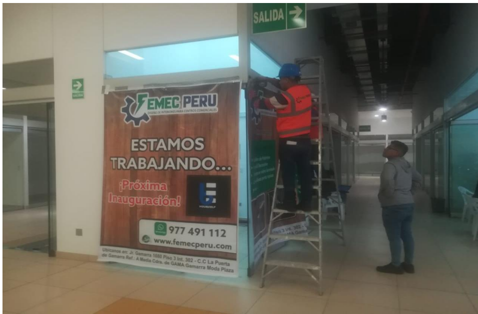
Anexo 8. Trabajos repetitivos
