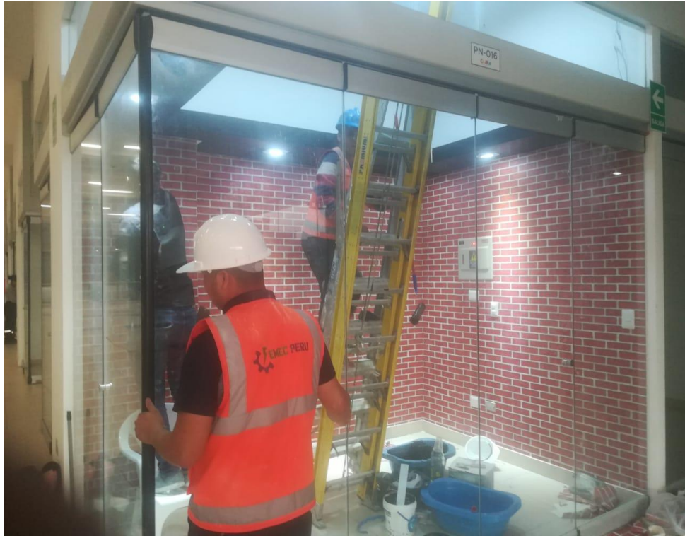
Anexo 11. Trabajos de instalación
