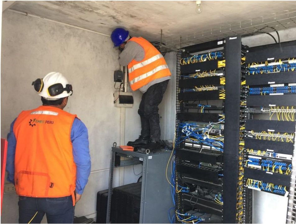
Anexo 9. Instalaciones en posiciones inadecuadas
