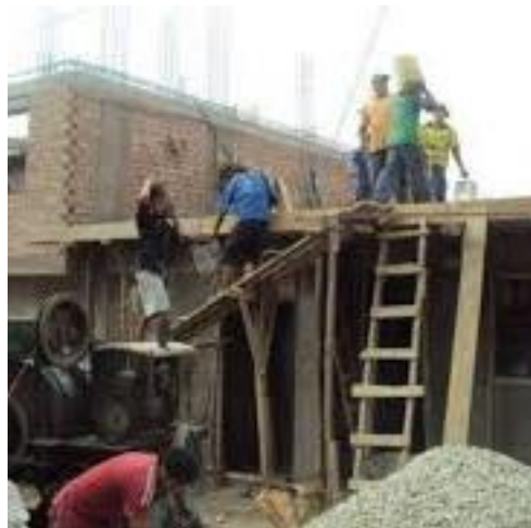
FIGURA 8. Construcción de viviendas sin supervisión técnica Fuente: Propia
