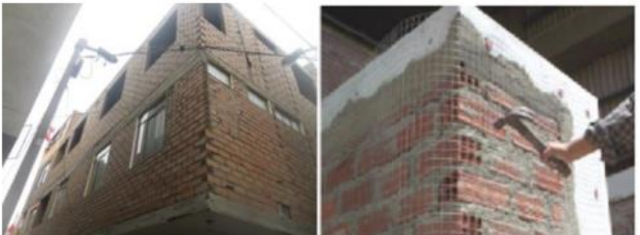
FIGURA 4. Refuerzo de voladizos y tabiquería sin arriostrar Fuente: PUCP – SENCICO
