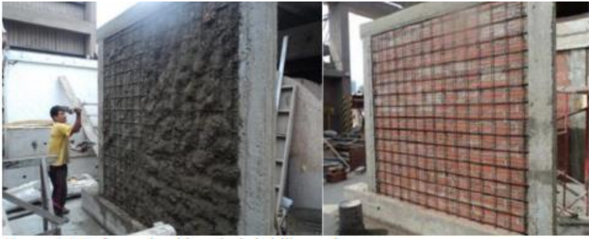
FIGURA 5. Refuerzo de ladrillo pandereta Fuente: PUCP – SENCICO
