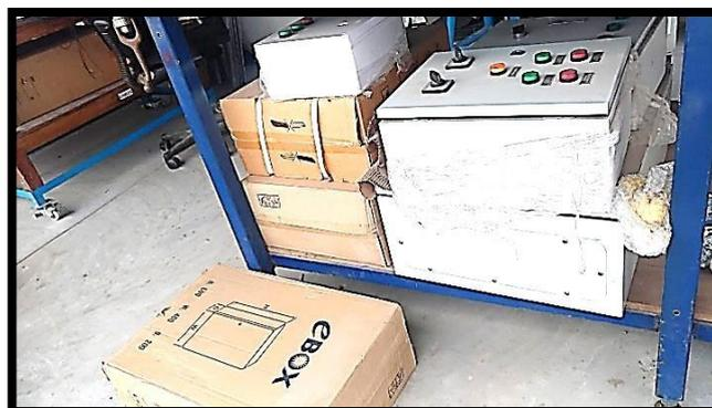
*Figura 7. Inadecuada ubicación de gabinetes metálicos.*
