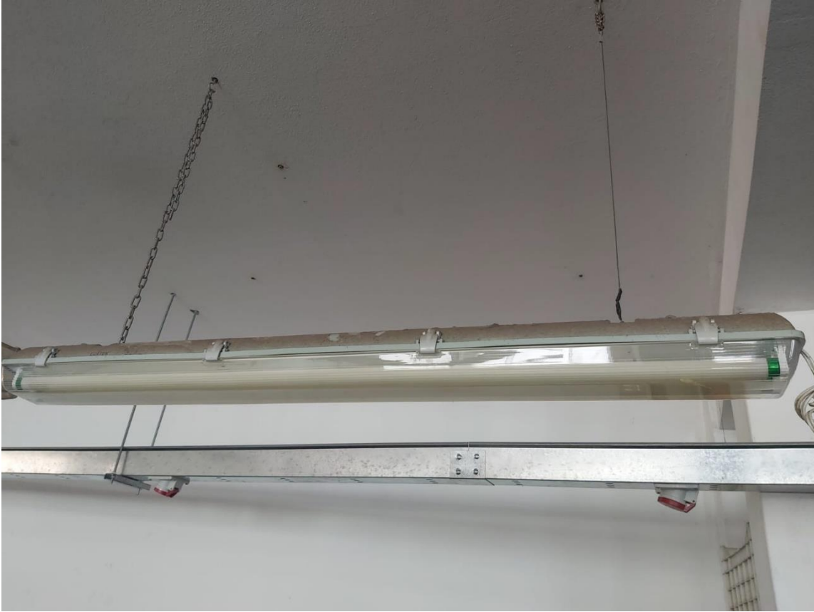
Figura 10: Aplicación de protector a los focos fluorescente e instalación de estructuras para cables eléctricos
