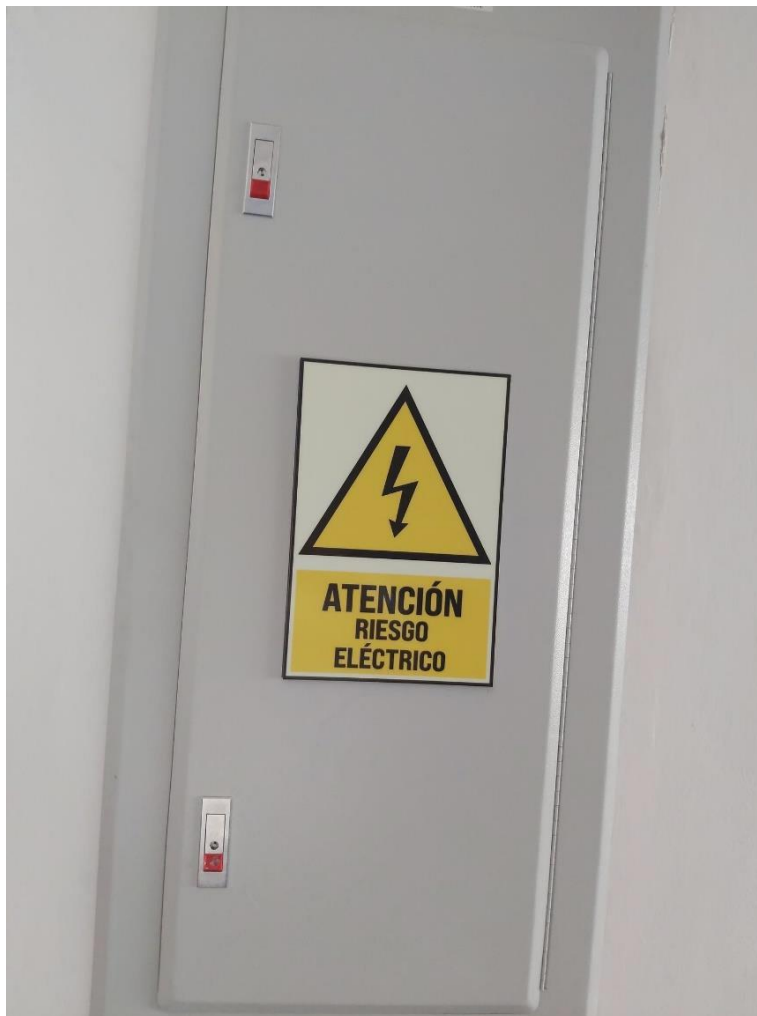
Figura 8: mejora de tablero eléctrico y señalizado
