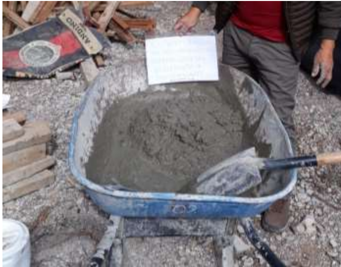
Figura N°31: Mezcla C muestra M3 del concreto F'c=210 kg/cm 2 en estado fresco con aditivo.
