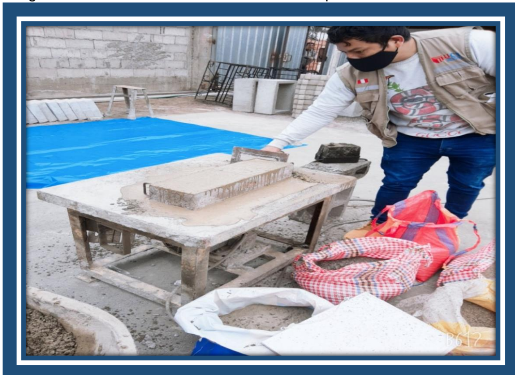
Imagen N° 16: Vaciado de Mezcla en el Molde para su vibración.
