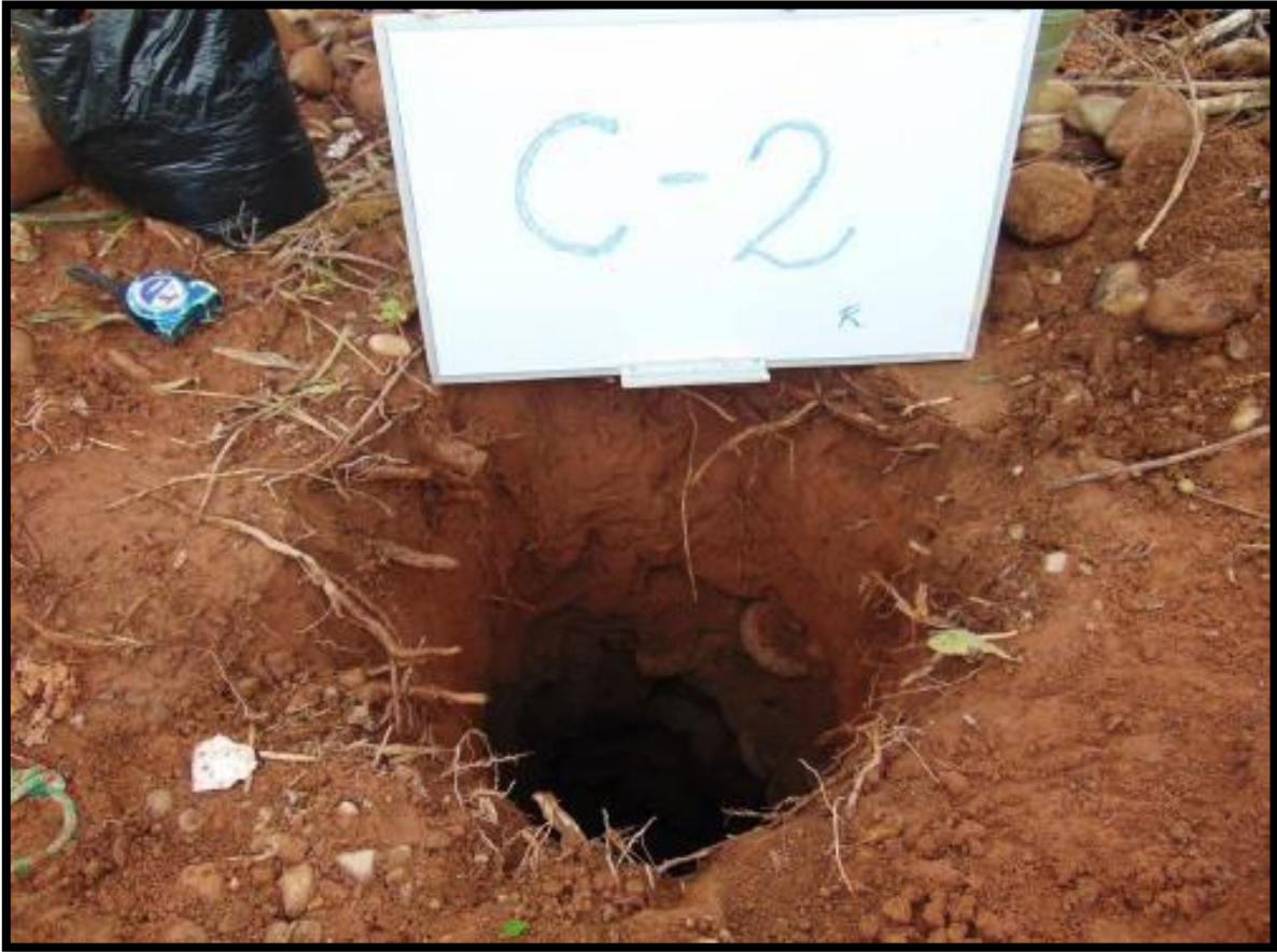
Calicata (C-2) para el estudio de suelo.
