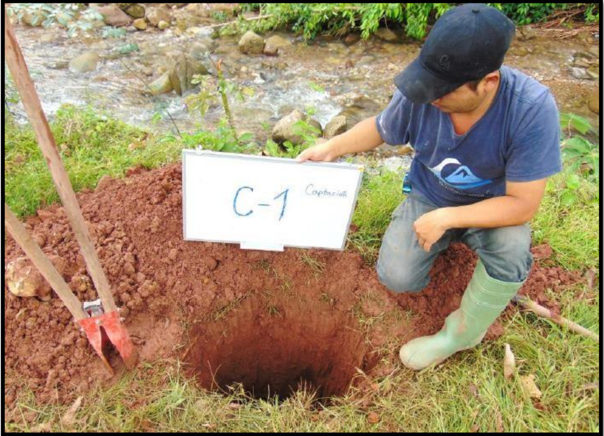
Calicata (C-1) para el estudio de suelo.
