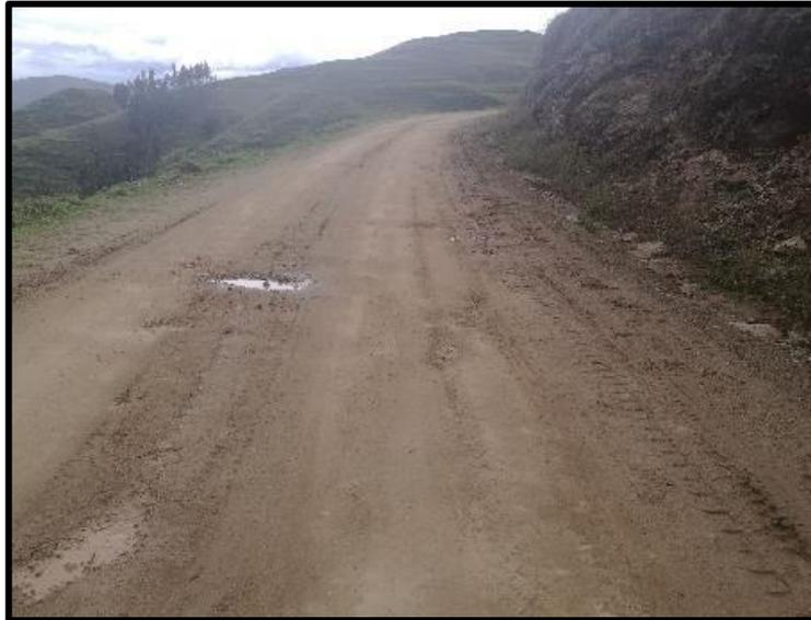
**Figura 3.** Presencia de ahuellamiento
