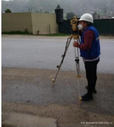
Fotografía N°5: En la siguiente imagen se aprecia la toma de puntos con la estación total marca topcon.
