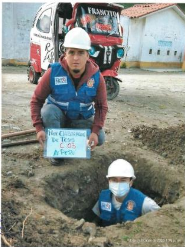
Foto N° 3: Se puede apreciar en la imagen la Av. Peru en la cuadra 04, la Calicata N° 03
