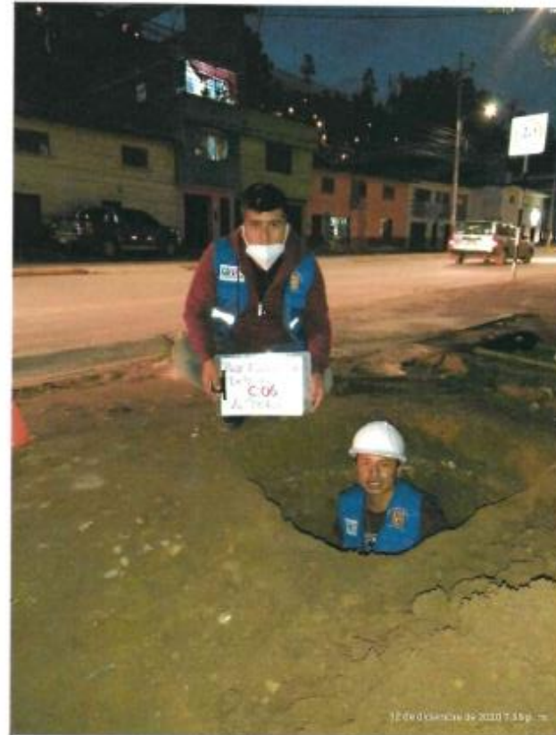
Foto N° 6: Se puede apreciar en la imagen la Av. Peru en la cuadra 10, la Calicata N° 06
