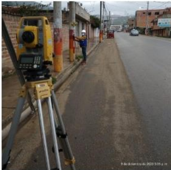
Fotografía N°4: Se puede apreciar el levantamiento topográfico tomándose los puntos topográficos tales como alumbrado público de la avenida Perú.
