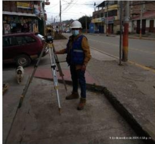
Fotografía N° 1: Se puede apreciar el levantamiento topográfico realizándose en las primeras cuadra de la avenida Perú.
