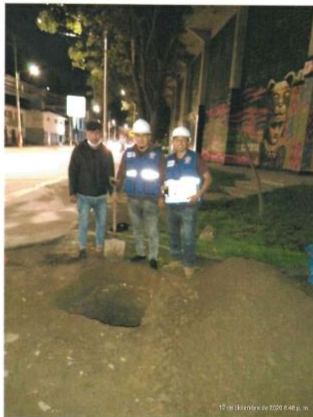
Foto N° : Se puede apreciar el término del sondeo de calicatas
