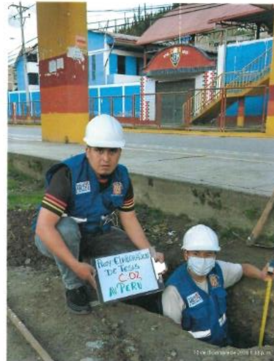
Foto N° 2: Se puede apreciar en la imagen la Av. Peru en la cuadra 04, la Calicata N° 02
