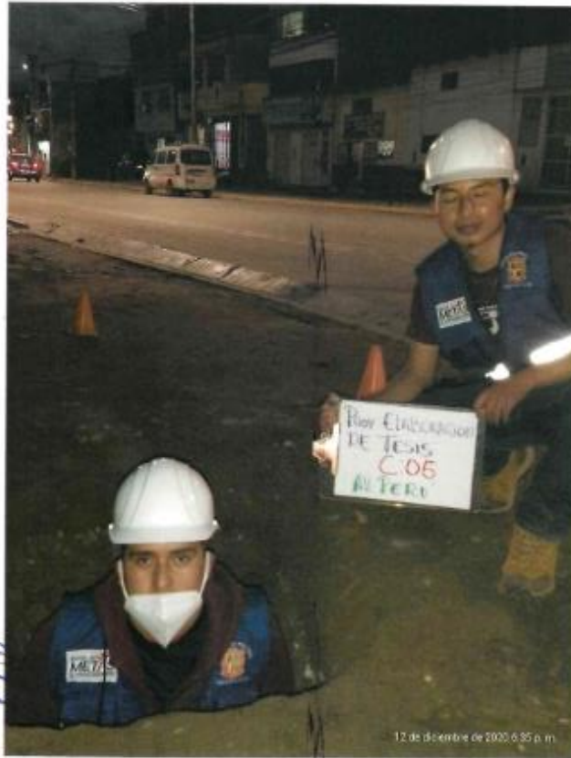
Foto N° 5: Se puede apreciar en la imagen la Av. Peru en la cuadra 8, la Calicata N° 05
