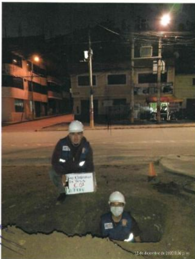
Foto N° 7: Se puede apreciar en la imagen la Av. Peru ultima cuadra, la Calicata N° 06
