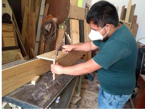
**Imagen 9.** Armado de las piezas de madera para el encofrado
