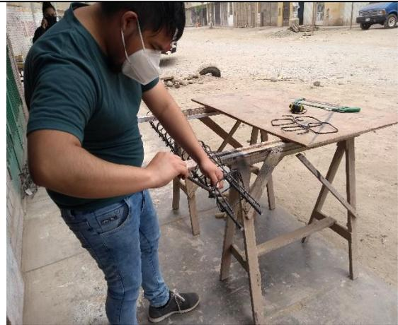
**Imagen 6.** Amarre de los estribos de fibra de vidrio con las barras longitudinales de fibra de vidrio
