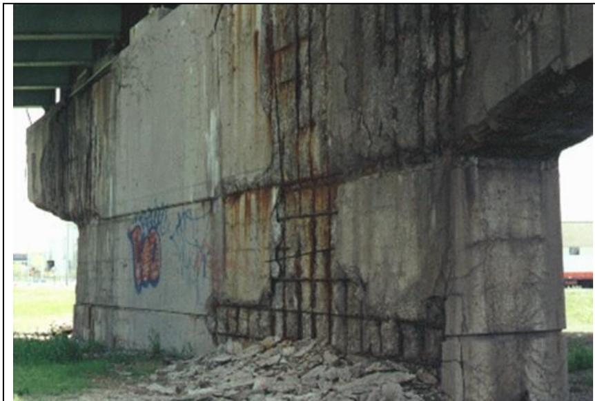
**Figura 3.** Corrosión en estructuras de puentes
