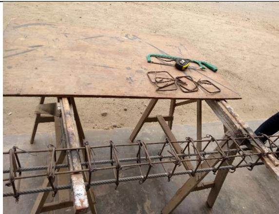
**Imagen 3.** Realización del amarre de estribos con varillas longitudinales de acero
