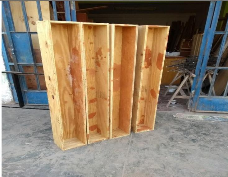
**Imagen 10.** Trabajo de los moldes de encofrado de las vigas finalizado
