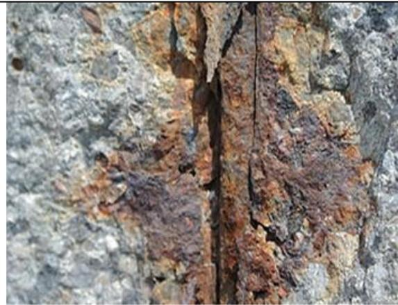
**Figura 2.** Varillas oxidadas en estructuras de puentes
