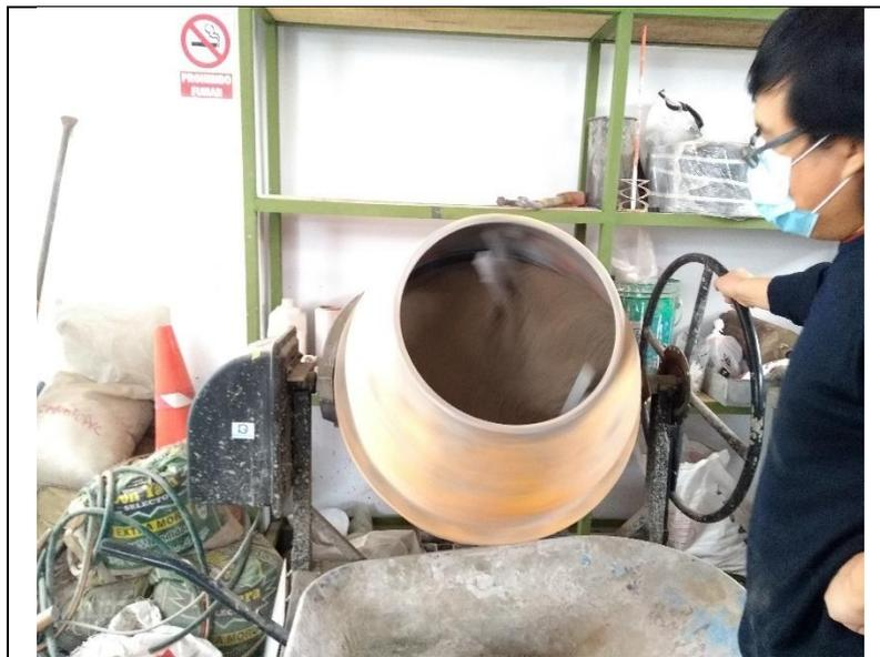
**Imagen 16.** Ejecución del equipo de mezcla, con la dosificación necesaria de agregados, para una mezcla  $F'c=210$  kg/cm<sup>2</sup>
