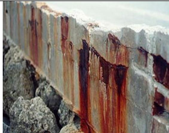
**Figura 1.** Corrosión en varillas de acero estructural
