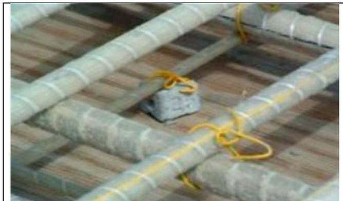
**Figura 7.** Barras de fibra de vidrio como armadura estructural
