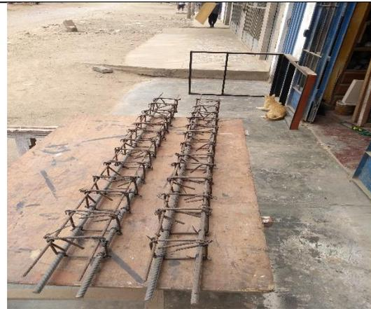
**Imagen 4.** Vigas con armaduras de acero finalizado
