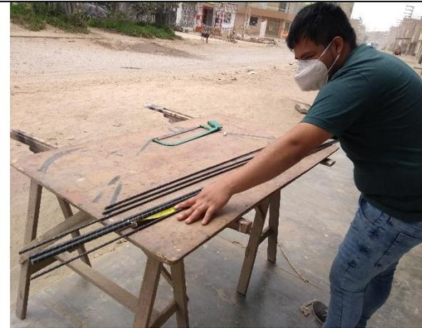
**Imagen 5.** Corte de las barras de fibra de vidrio, para su próximo armado
