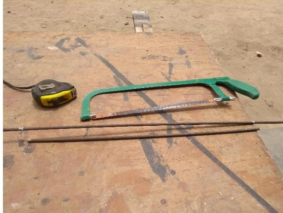
**Imagen 1.** Corte de acero para su próximo armado
