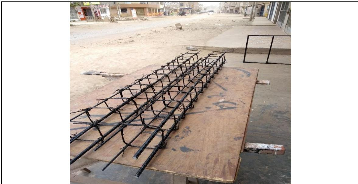
**Imagen 7.** Refuerzo de armadura con barras de fibra de vidrio finalizado
