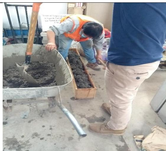
**Imagen 20.** Llenado a nivel, de mezcla de concreto, en los moldes de viga
