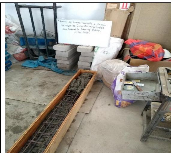
**Imagen 19.** Incorporación de la mezcla de concreto y armaduras, dentro de los moldes de viga
