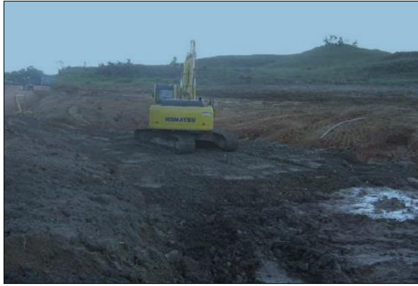
Figura 7. Preparación del terreno.
