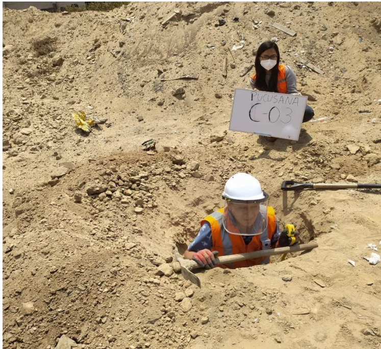
Fotografía 3. Calicata C-03 en la progresiva 1+250.00 de la Vía ingreso a Pucusana.
