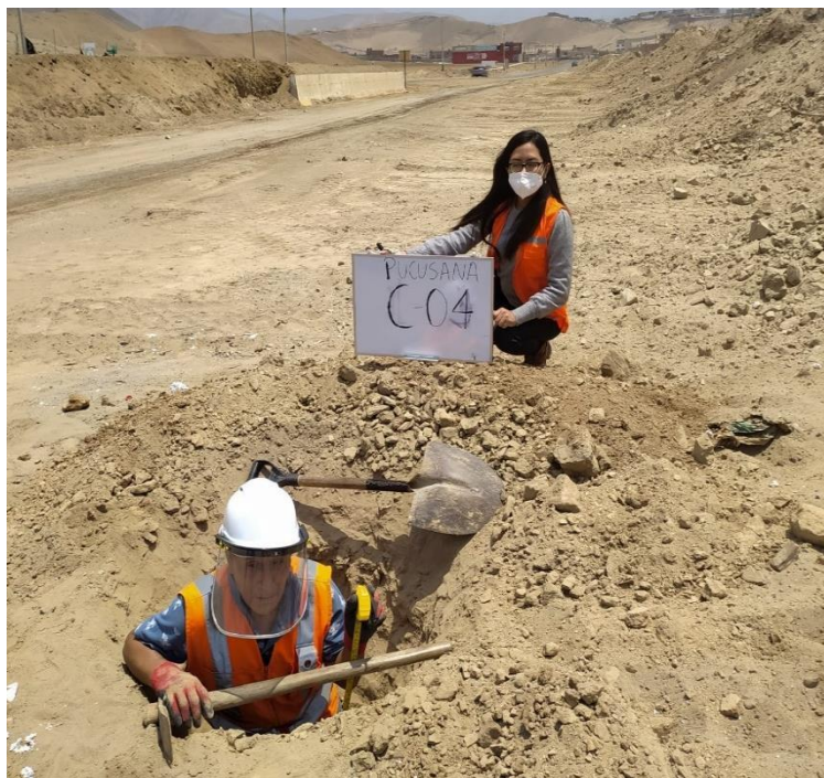
Fotografía 4. Calicata C-04 en la progresiva 1+850.00 de la Vía ingreso a Pucusana.
