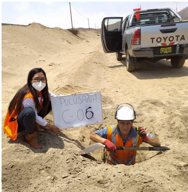
Fotografía 6. Calicata C-06 en la progresiva 2+850.00 de la Vía ingreso a Pucusana.
