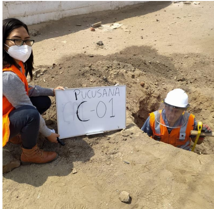
Fotografía 1. Calicata C-01 en la progresiva 0+450.00 de la Vía de ingreso a Pucusana.
