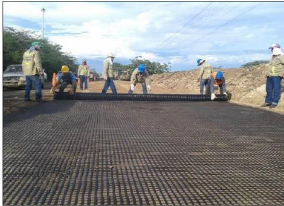
Figura 8. Colocación de geomalla biaxial
