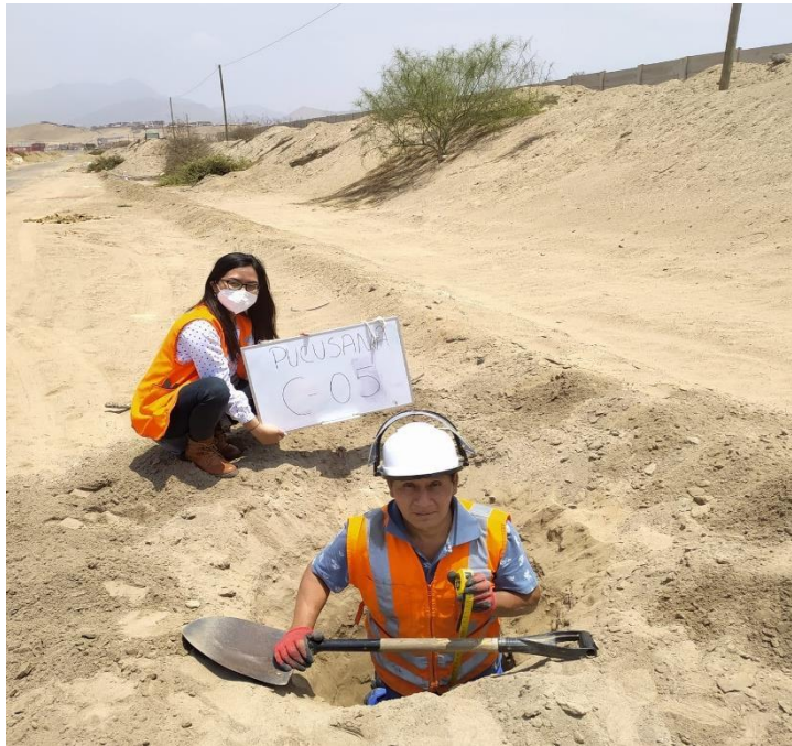
Fotografía 5. Calicata C-05 en la progresiva 2+250.00 de la Vía ingreso a Pucusana.
