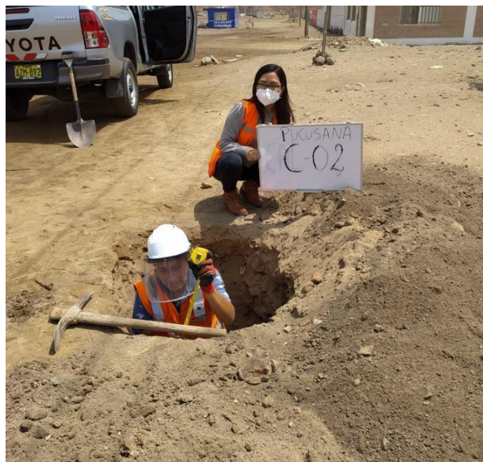
Fotografía 2. Calicata C-02 en la progresiva 0+850.00 de la Vía ingreso a Pucusana.
