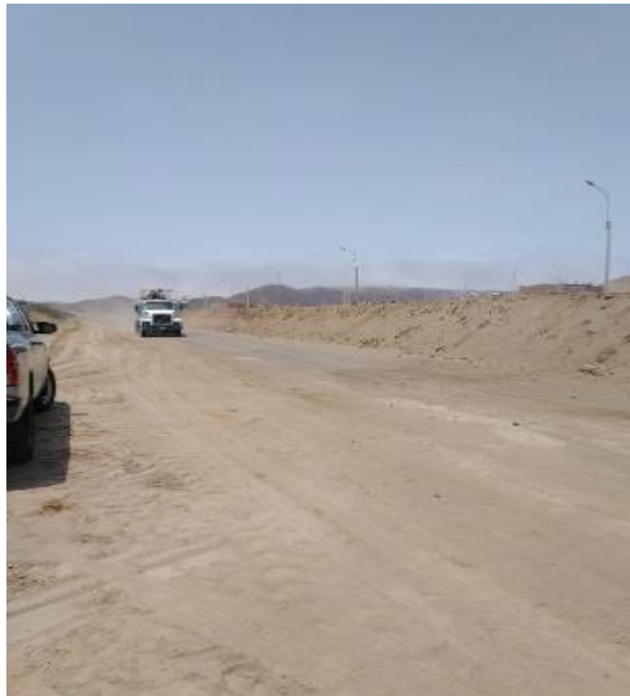
Fotografía 21. Tramo progresiva 2+950.00 sin pavimentar.
