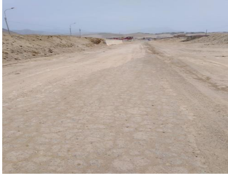
Figura 18. Tramo 1+350 m de la vía de acceso a Pucusana.
