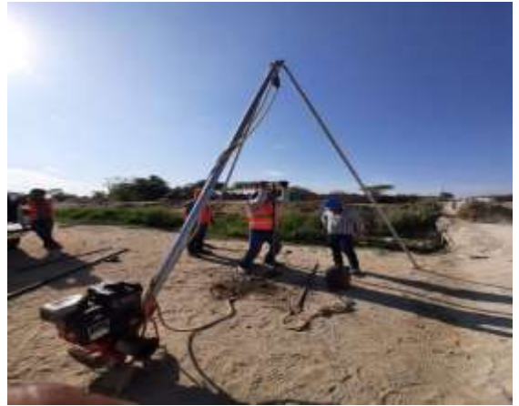
figura 18.13. perforación para la calicata 2
