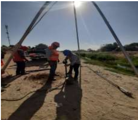
figura 18. 6. perforación a través del tubo en la calicata.
