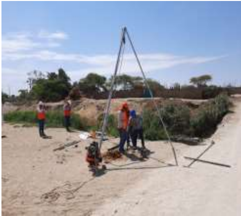
figura 18.14. verificando para realizar calicata 2
