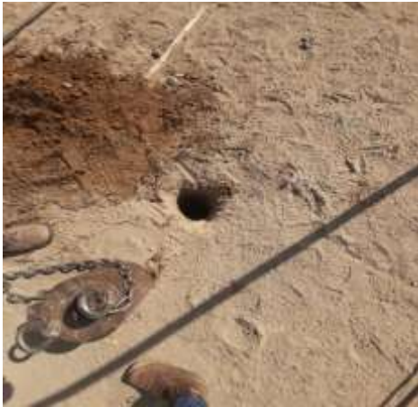
figura 18. 4. ejecución de la calicata 1
