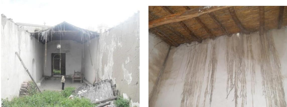
Figura 1:Techo en estado de colapso    Figura 2:Filtración del tejado en muros
