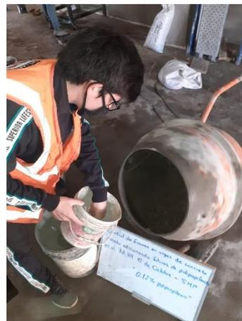
Descripción: Adición de la fibra de polipropileno en el concreto
