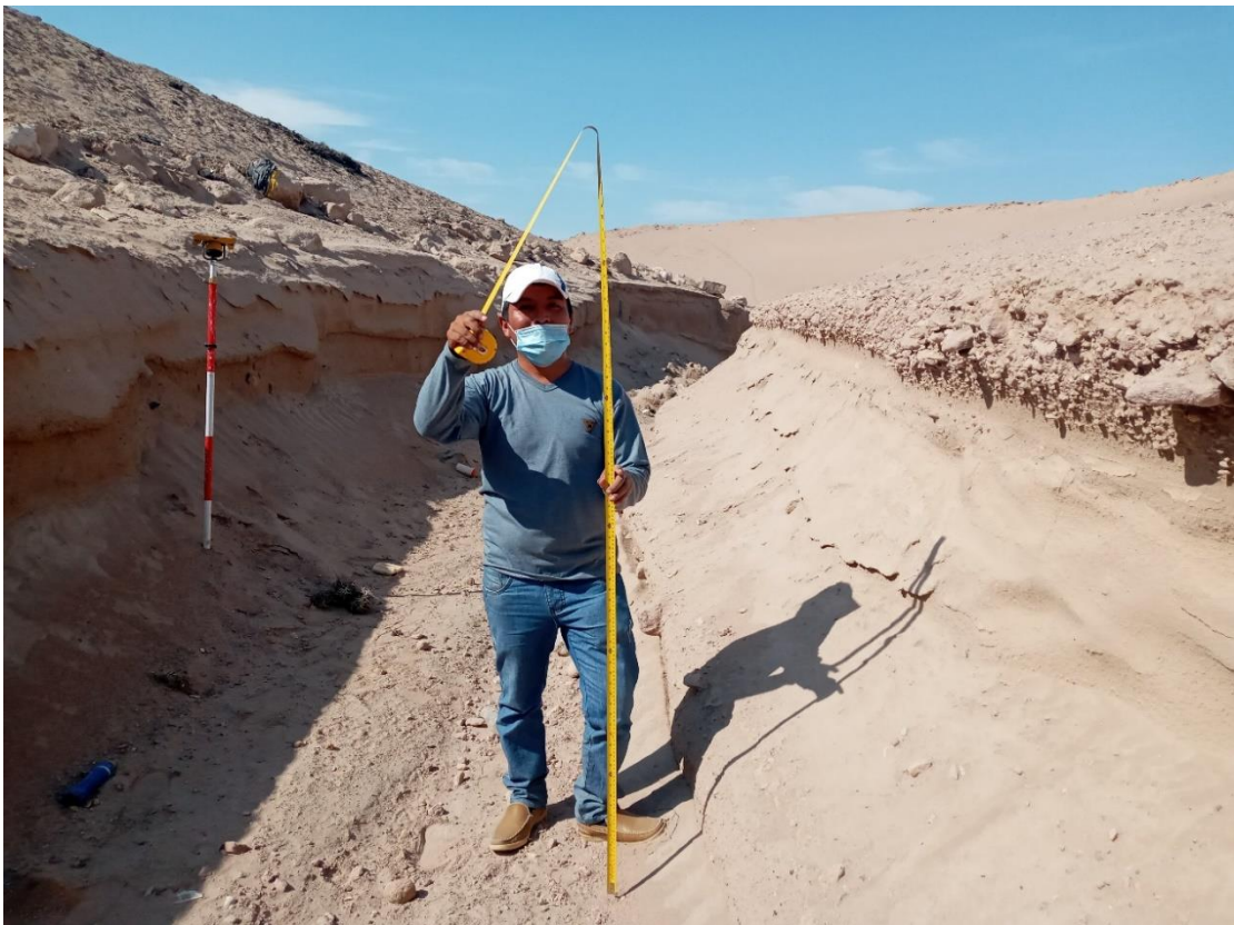
Foto 10: Verificación de socavacion alcanzado en activación de la Quebrada el 21 de febrero del 2020.
