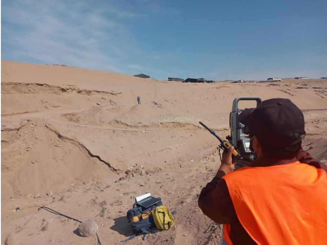
Foto 09: Trabajos de levantamiento Topográfico
