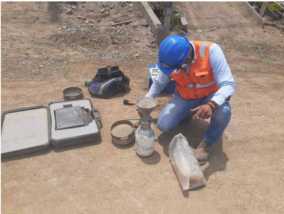
Figura 50: Ensayo de densidad y peso específico del suelo
