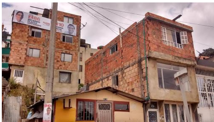
Figura 1: Peligro de construcciones en Albañilería confinada.
