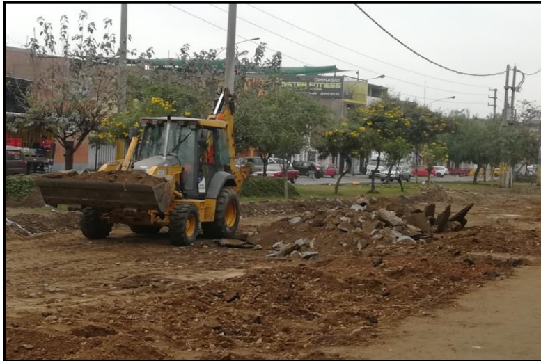
Fotografía N° 27: Remoción de la carpeta asfáltica- vía malecón Checa
