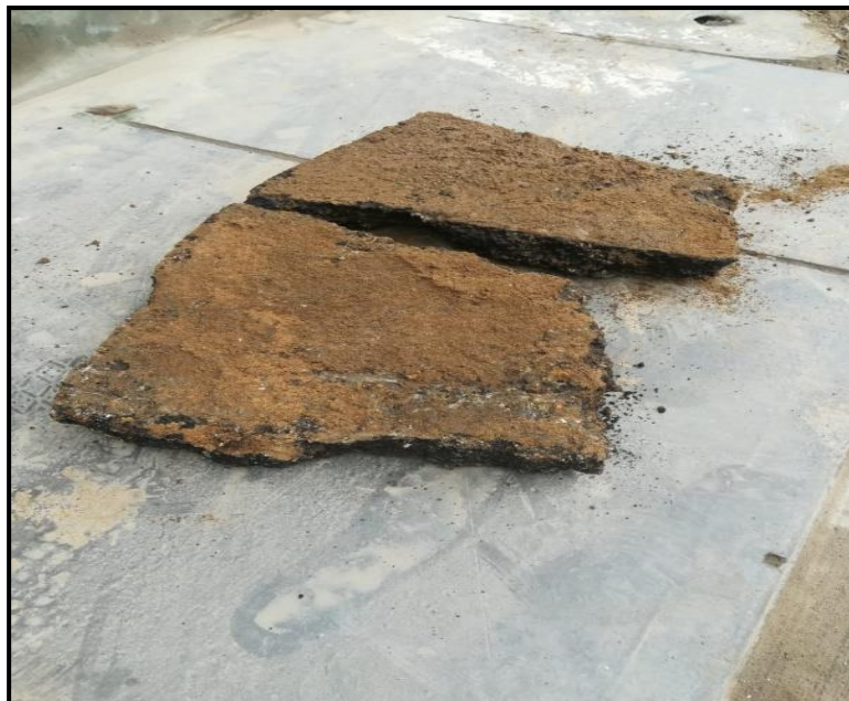
Fotografía N° 28: Bloques extraídos del reciclado asfáltico de pavimento
