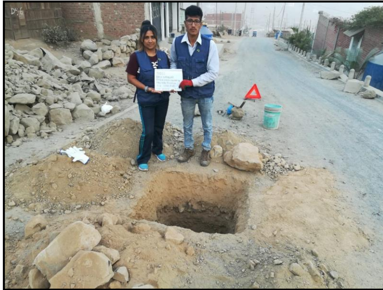
Fotografía N° 22: Fotografía panorámica de Excavación
