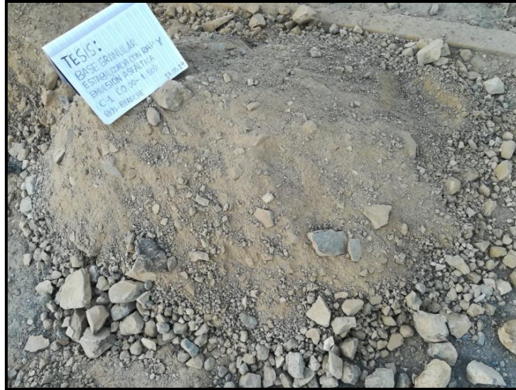
Fotografía N° 8: Extracción del primer estrato C1
