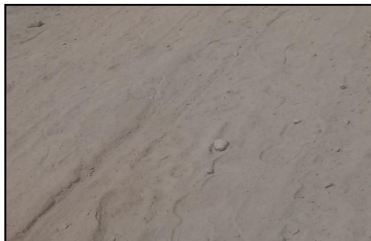
Fotografía N° 3: Erosión en la avenida los frutales
