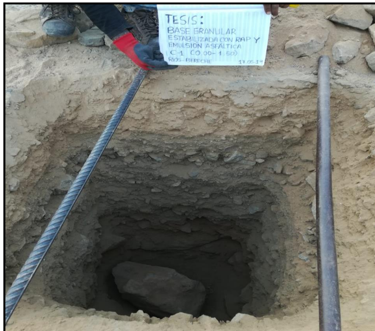
Fotografía N° 13: Excavación terminada de calicata 1
