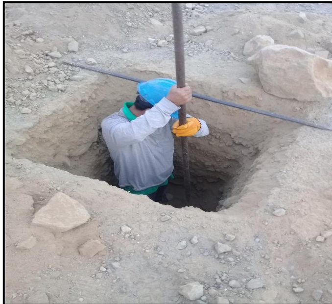
Fotografía N° 6: Excavación de calicata 1
