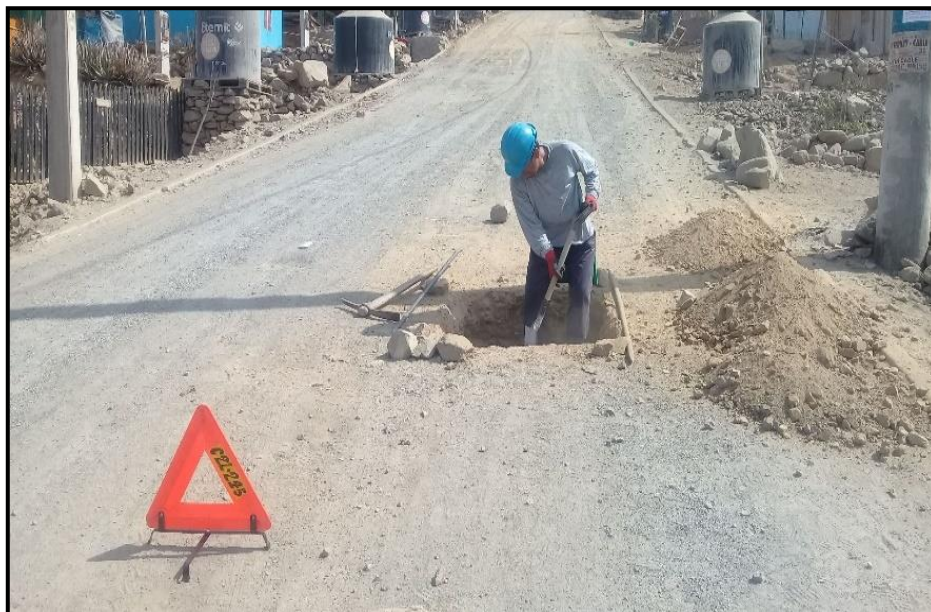
Fotografía N° 24: Extracción de la base granular
