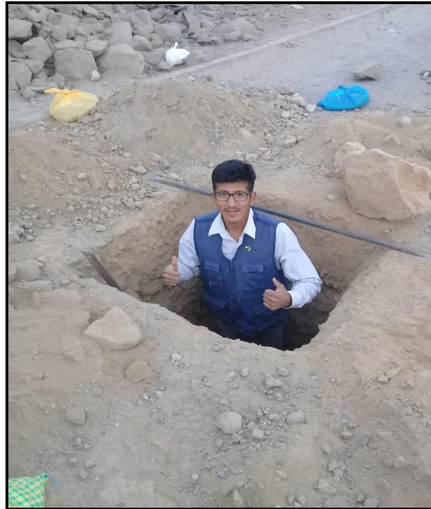
Fotografía N° 25: Extracción de la base granular
