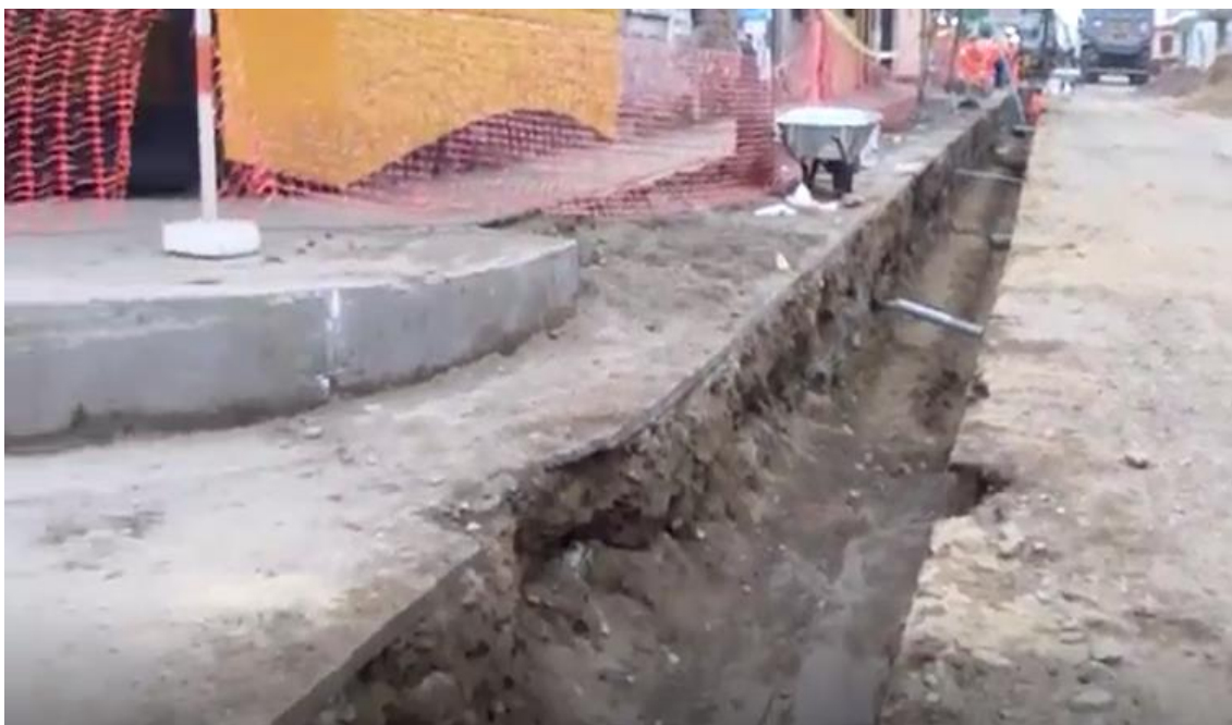
Figura N°07 Excavaciones de una línea de alcantarillado
