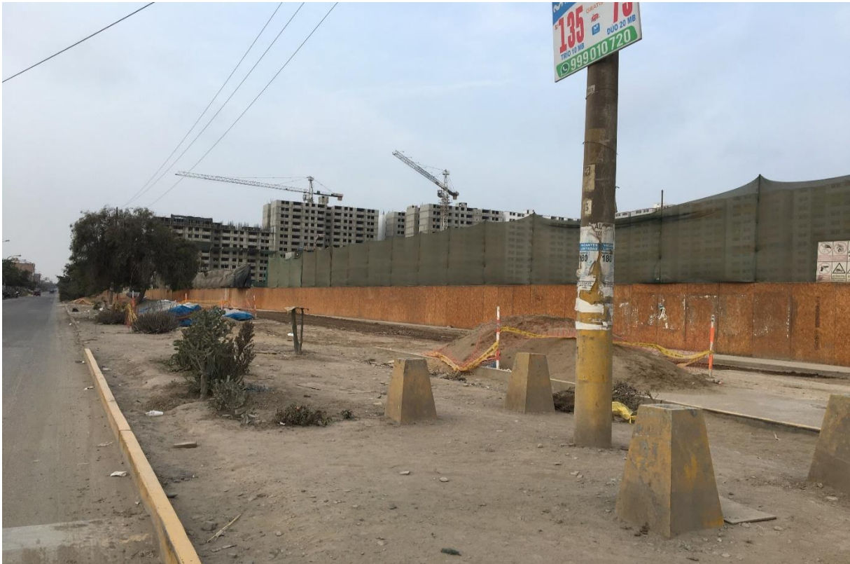
Foto: Expansión de cobertura de redes por crecimiento vertical (edificios) en Los Condominios de Sol de Collique
