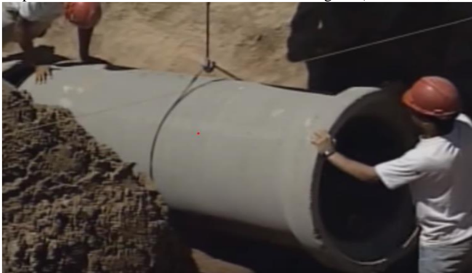
Figura N°14 Tuberías de concreto
