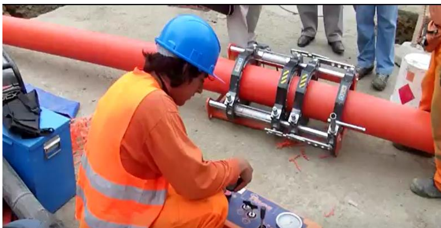
Figura N°13. Empalme de tuberías de PVC
