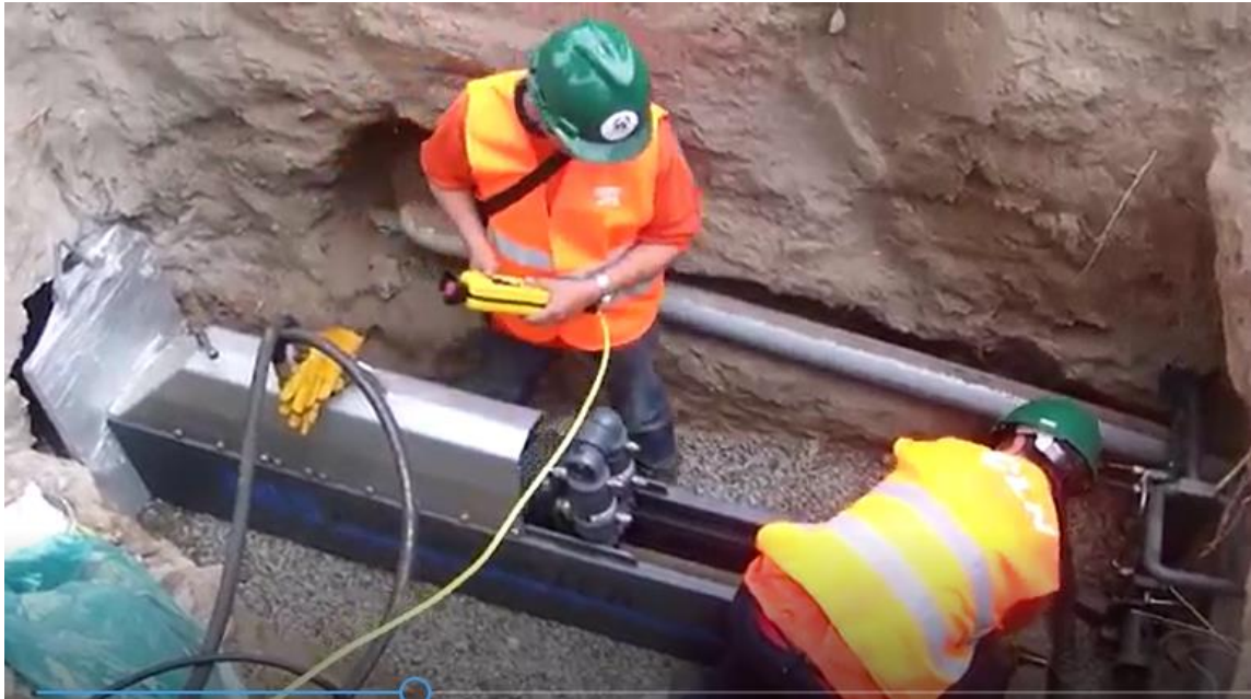
Figura N°08 Uso del equipo de Cracking
