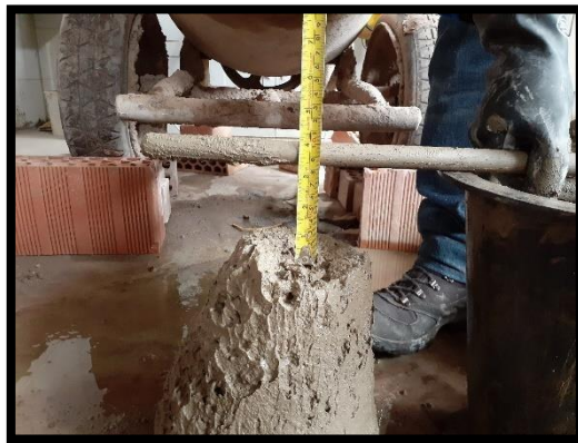
Cono de Abrams, medición de slump
