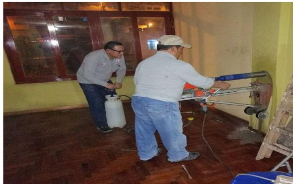
figura 19: Extracción de testigos de diamantina
