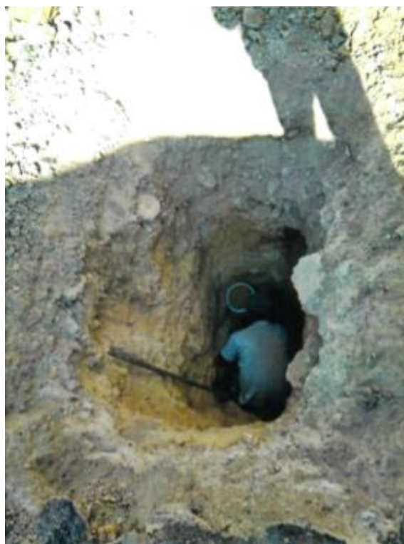
Figura 69. Excavación de la calicata
