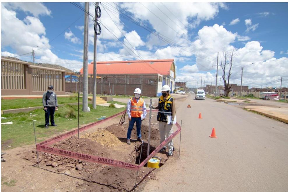
Figura N° 01: trabajos de campo excavación de calicatas.
