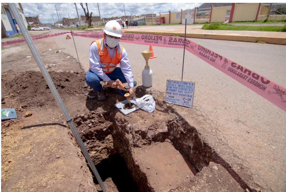
Figura N° 02: trabajos de campo ensayo densidad de campo.
