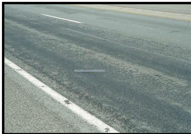
Figura N° 9 Nivel Alto (2H). Fuente: FHWA-HRT-13-092, 2014, p.26.
