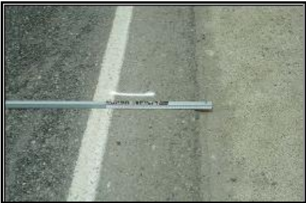
Figura N° 32 Nivel Bajo (9L). Fuente: FHWA-HRT-13-092,2014, p.30.
