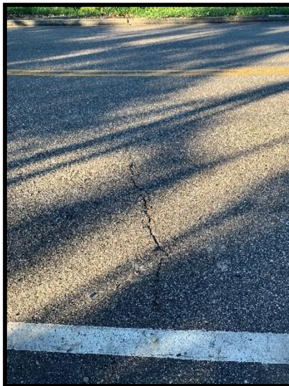
Figura N° 38 Nivel Alto (10H). Fuente: Elaboración propia.
