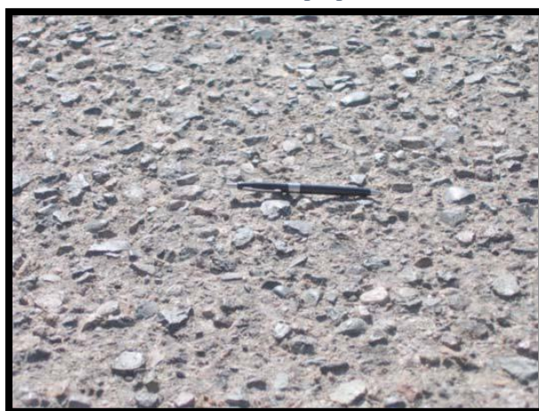
Figura N° 69 Nivel Alto (20H). Fuente: ASTM D6433-18, 2018, p.24.
