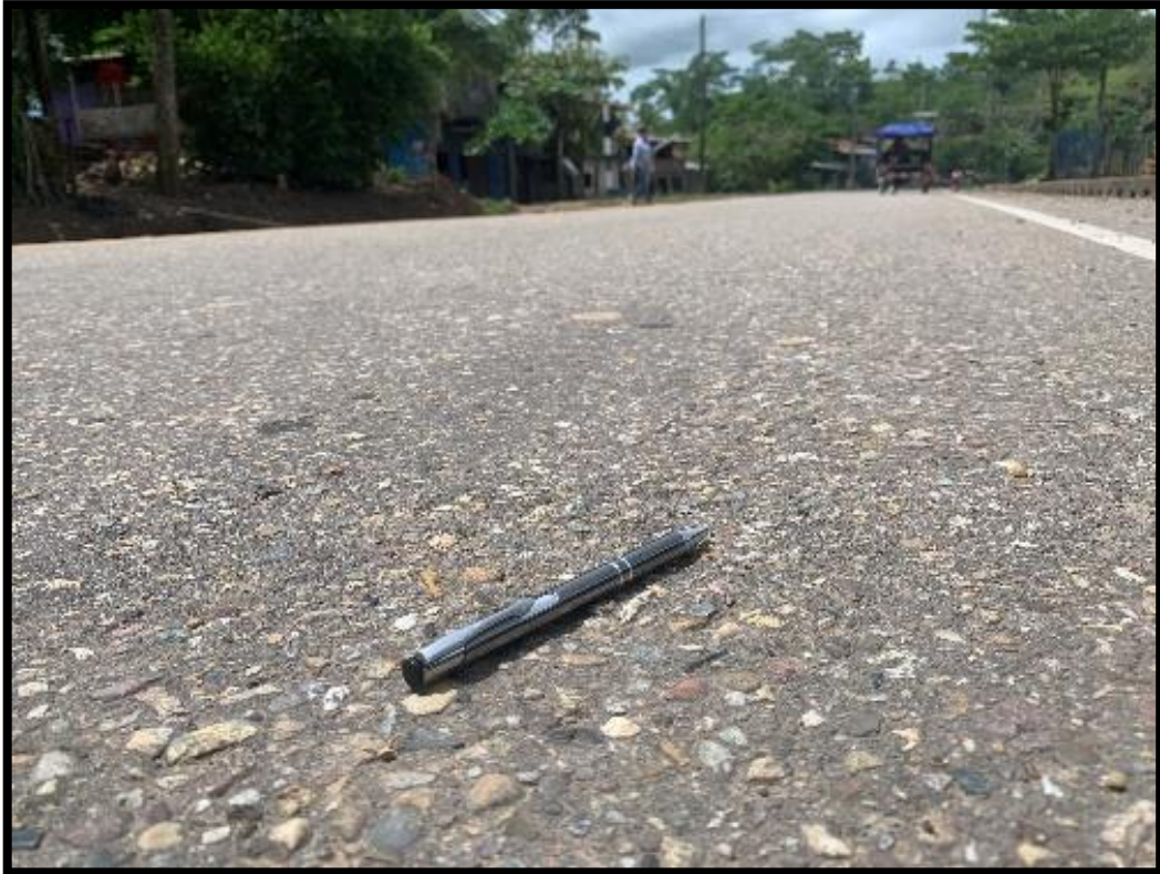
Figura N° 43 Pulimento de Agregados. Fuentes: Elaboración propia.
