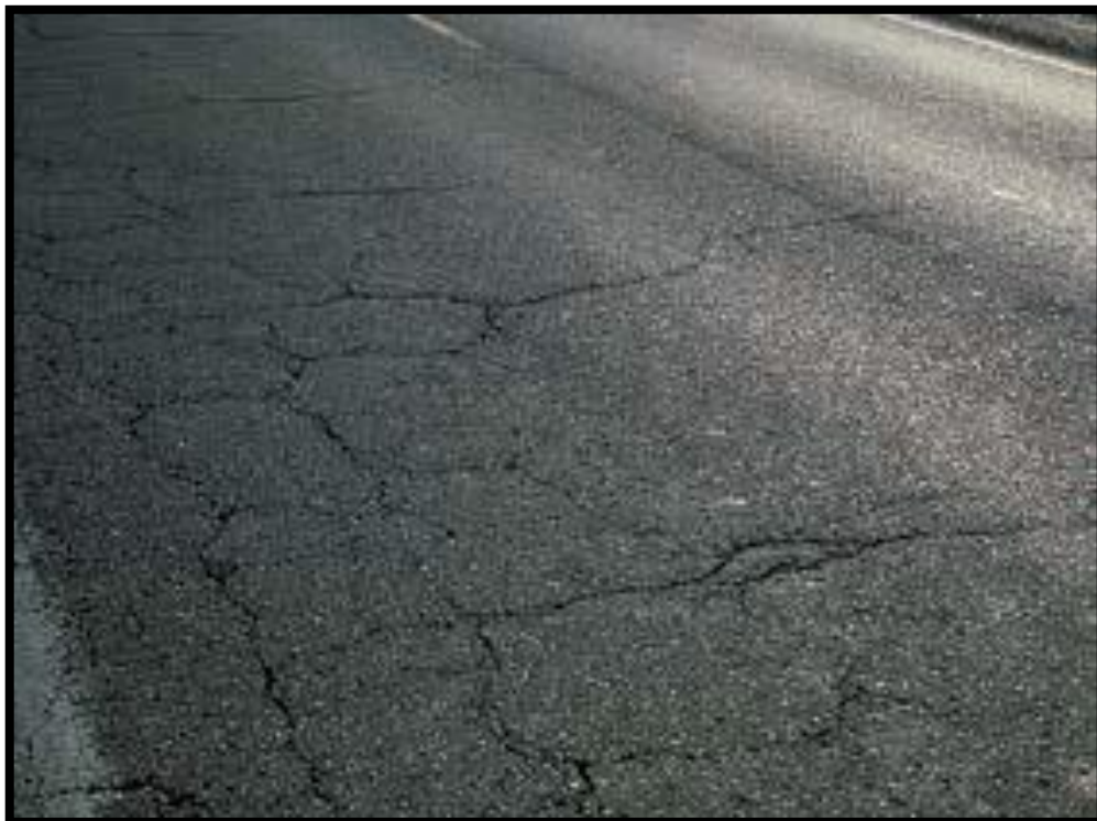
Figura N° 13 Nivel Alto (3H). Fuente: FHWA-HRT-13-092, 2014, p.6.
