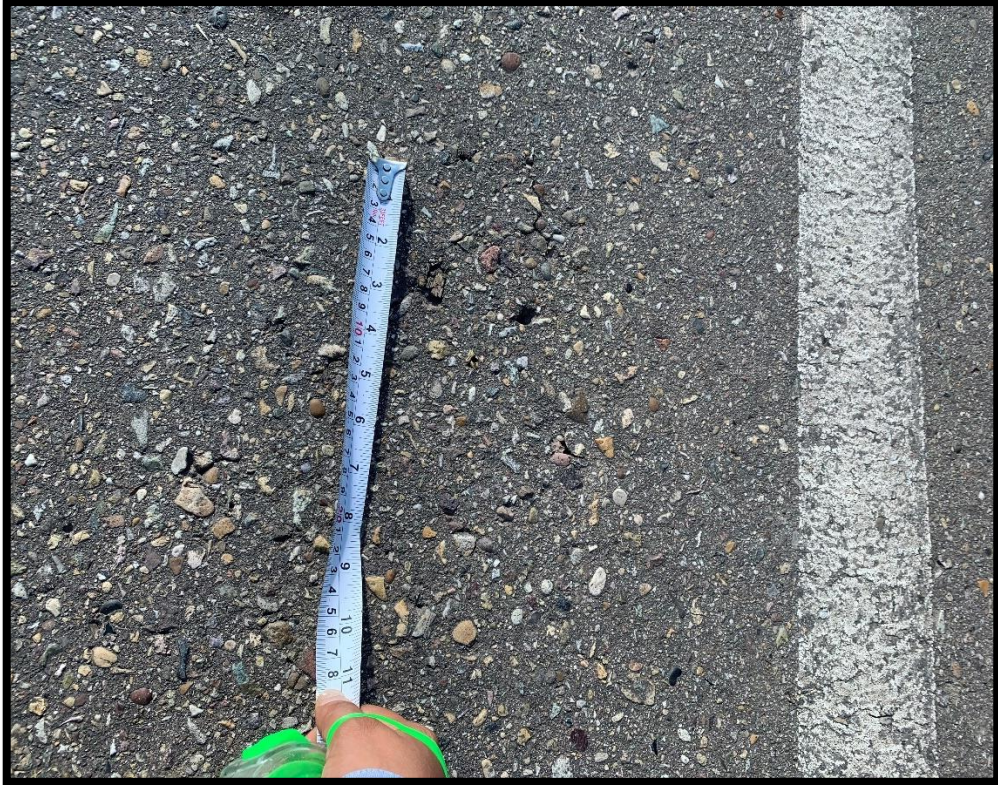
Ilustración 21: Meteorización
