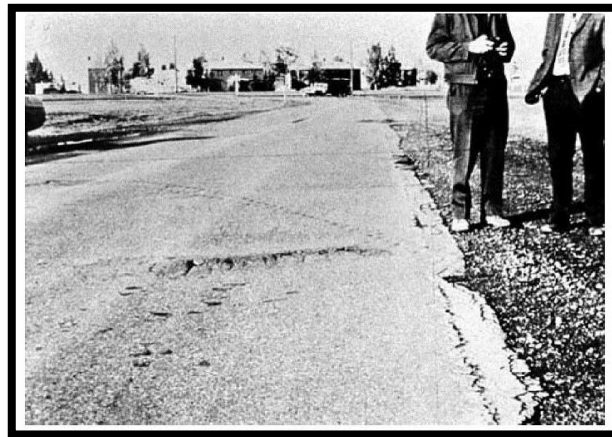
Figura N° 15 Nivel Medio (4M). Fuente: ASTM D-6433.
