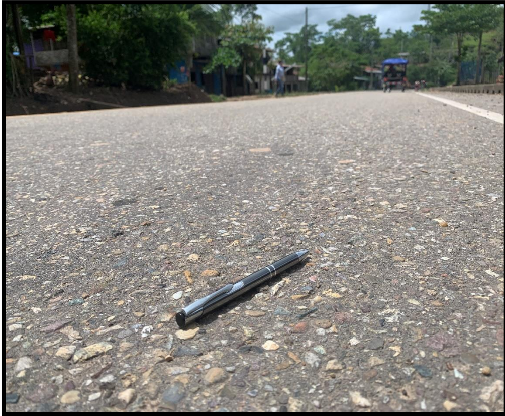
Ilustración 17: Pulimento de Agregados
