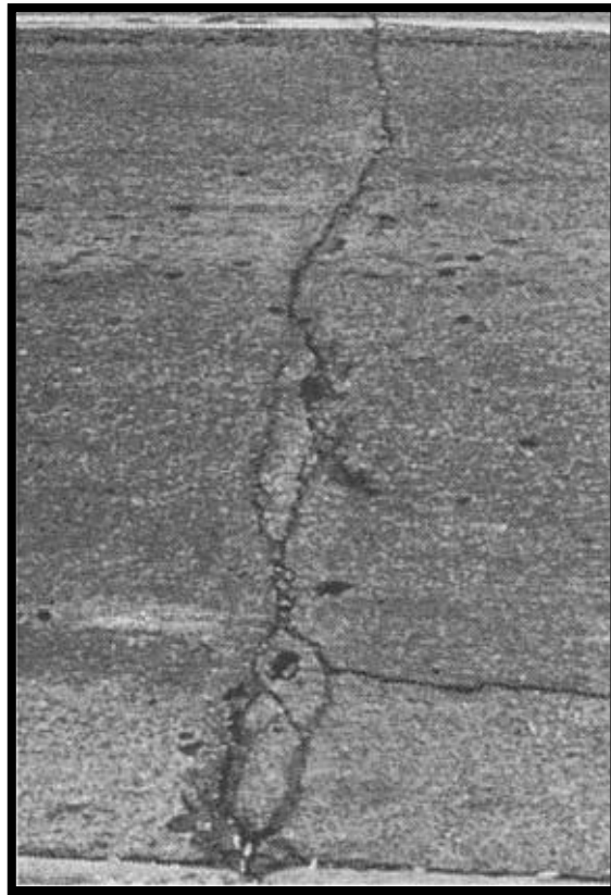
Figura N° 29 Nivel Medio (8M). Fuente: Shahin, M. Y., 2005, p.369.
