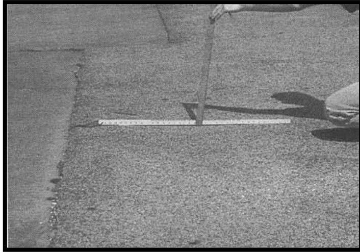
Figura N° 57 Nivel Bajo (16L). Fuente: Shahin, M. Y., 2005, p.385.
