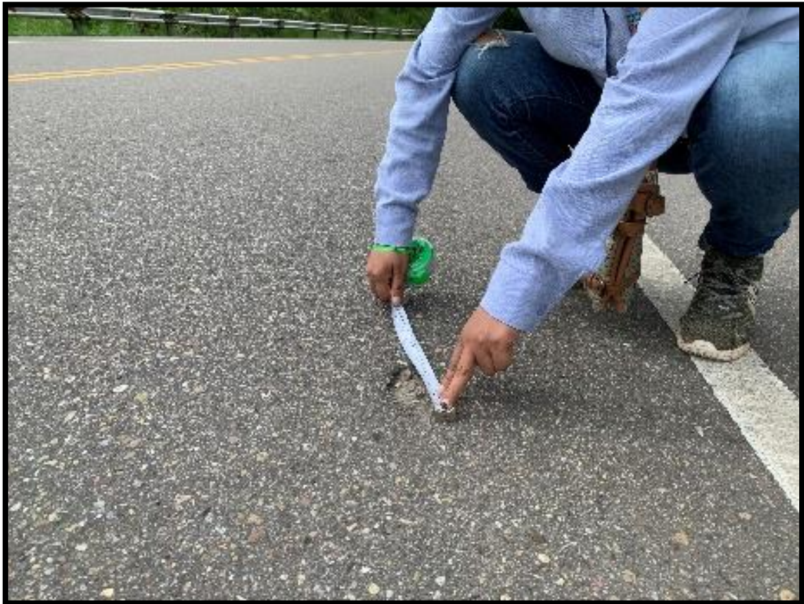
Figura N° 46 Nivel Bajo (13L). Fuente: Elaboración propia.
