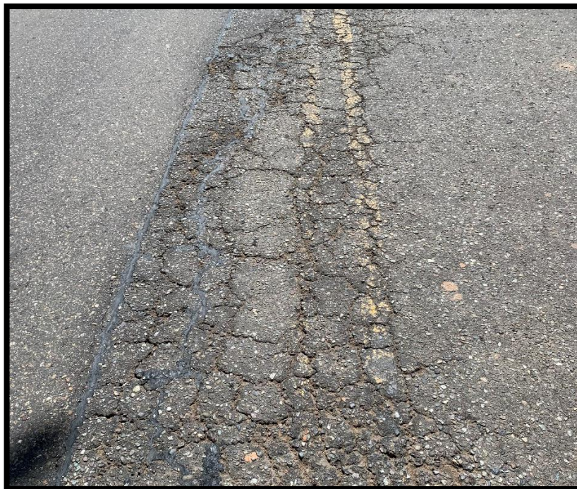
Figura N° 6 Nivel Alto (1H). Fuente: Elaboración propia.
