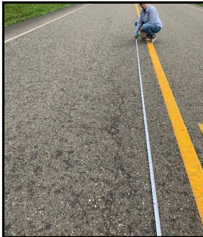
Figura N° 4 Nivel Bajo (IL) Fuente: Elaboración propia.
