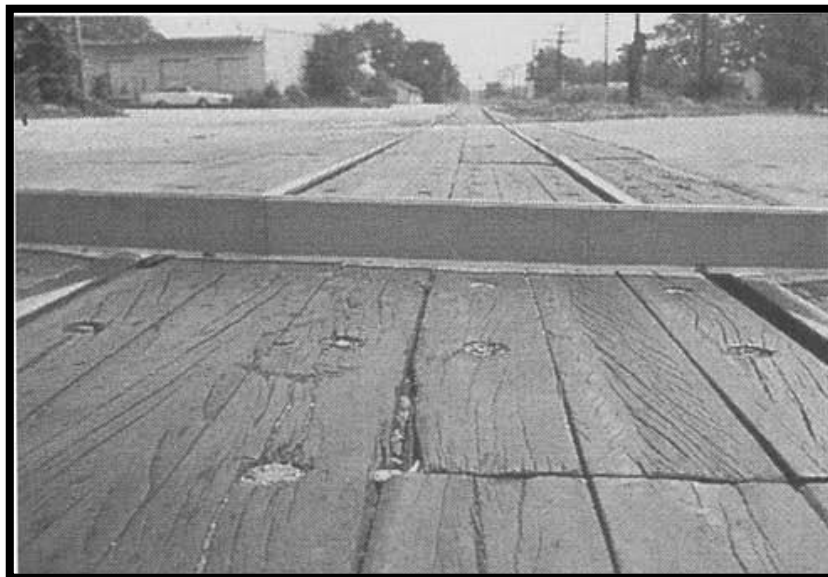
Figura N° 49 Nivel Bajo (14L). Fuente: Shahin, M. Y., 2005, p.381.
