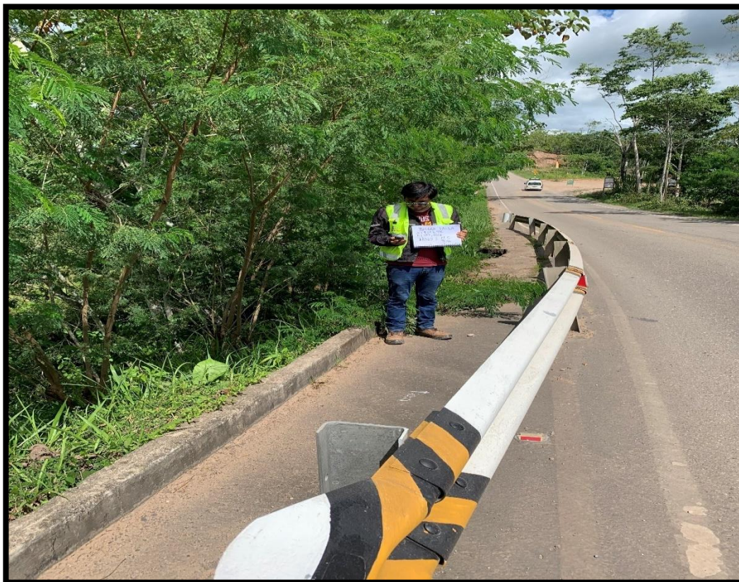
Ilustración 24: Tercera Falla Crítica - Falla no catalogada por el PCI.
