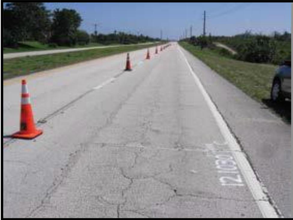
Figura N° 12 Nivel Medio (3M). Fuente: FHWA-HRT-13-092, 2014, p.6.
