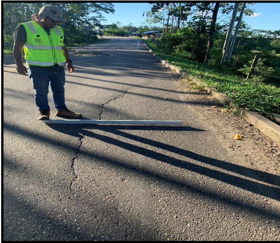
Ilustración 11: Abultamientos y Hundimientos
