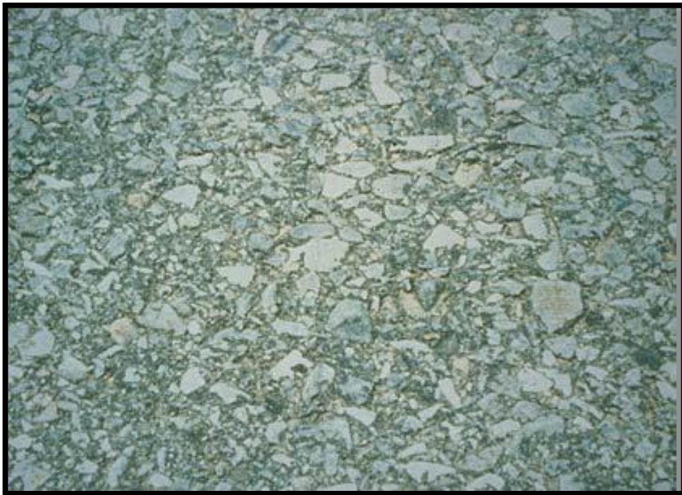
Figura N° 44 Pulimento de Agregados. Fuente: Shahin M. Y., 2005, p.377.
