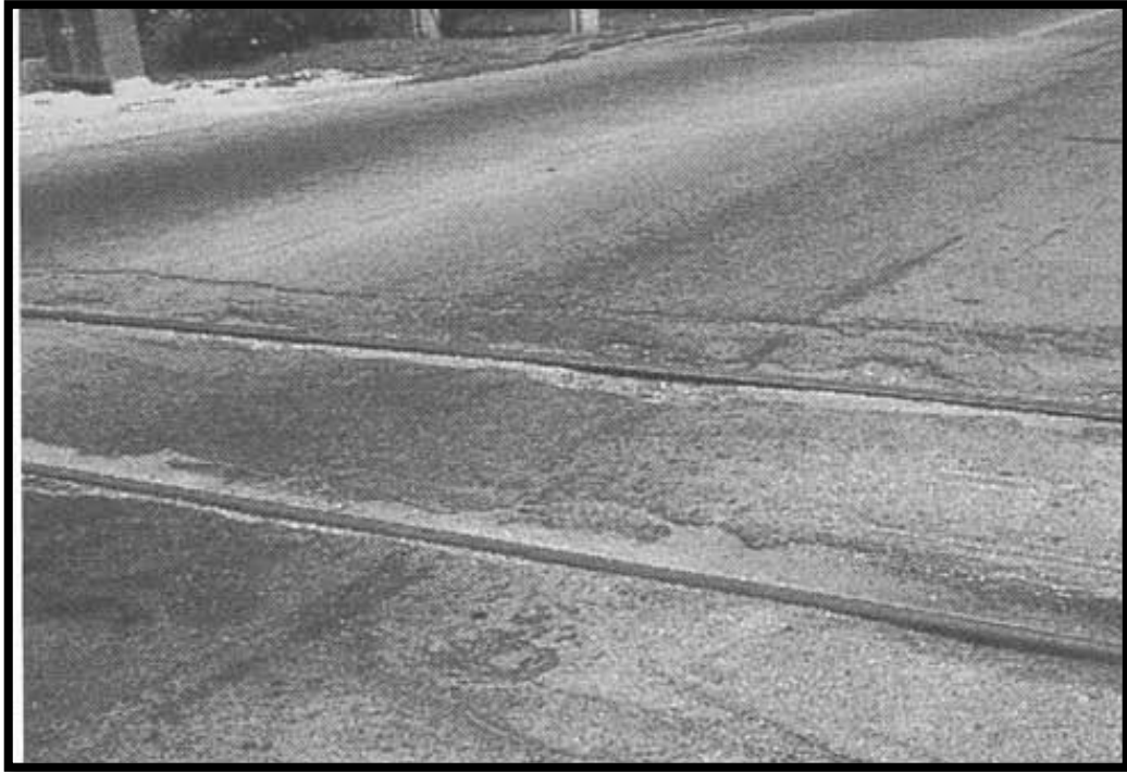
Figura N° 50 Nivel Medio (14M). Fuente: Shahin, M. Y., 2005, p.381.
