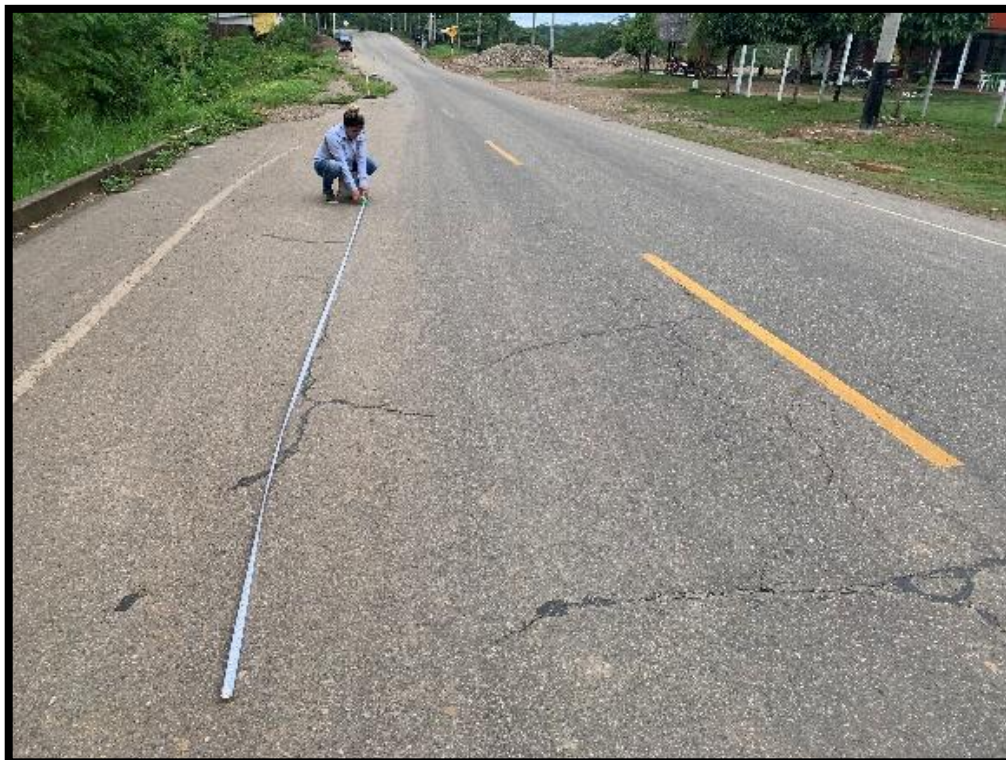
Figura N° 11 Nivel Bajo (3L). Fuente: Elaboración propia.
