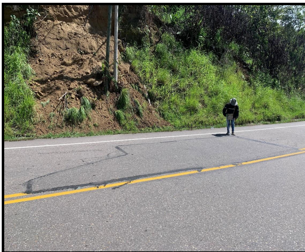
Ilustración 16: Parcheo y Acometidas de Servicio.
