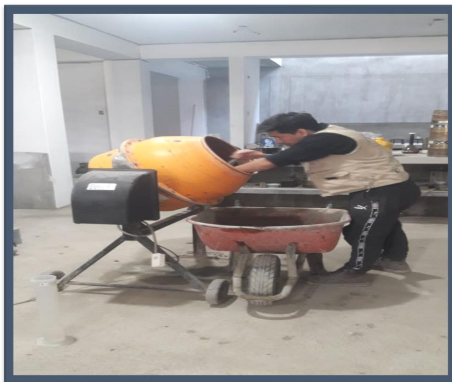
Foto 17. Vertiendo los agregados en la mezcladora
