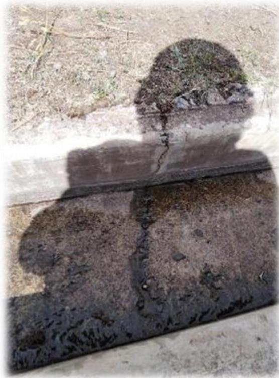
Figura 12.- Vista de perdidas por fisura
