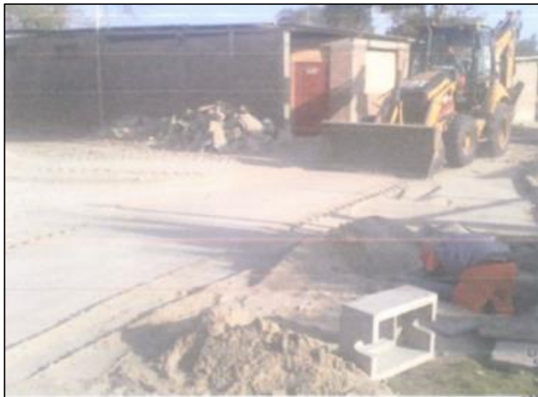
Figura 45. Instalación Conexión Domiciliaria
