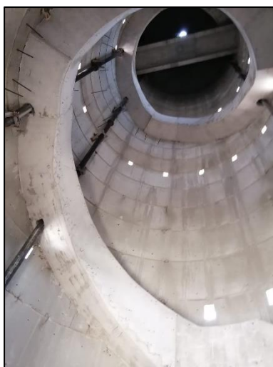
Figura 32. Vista Interior del REP
