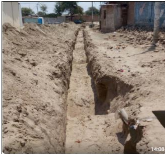
Figura 39. Relleno de Zanja
