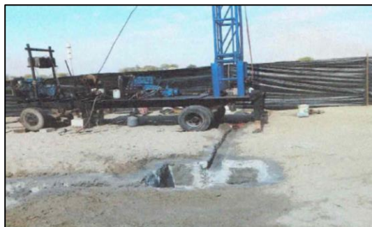
Figura 11. Instalación de Equipos de Perforación.
