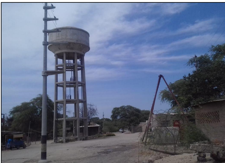
Figura 9. Reservorio La Legua y Pozo La Legua IRHS02.
