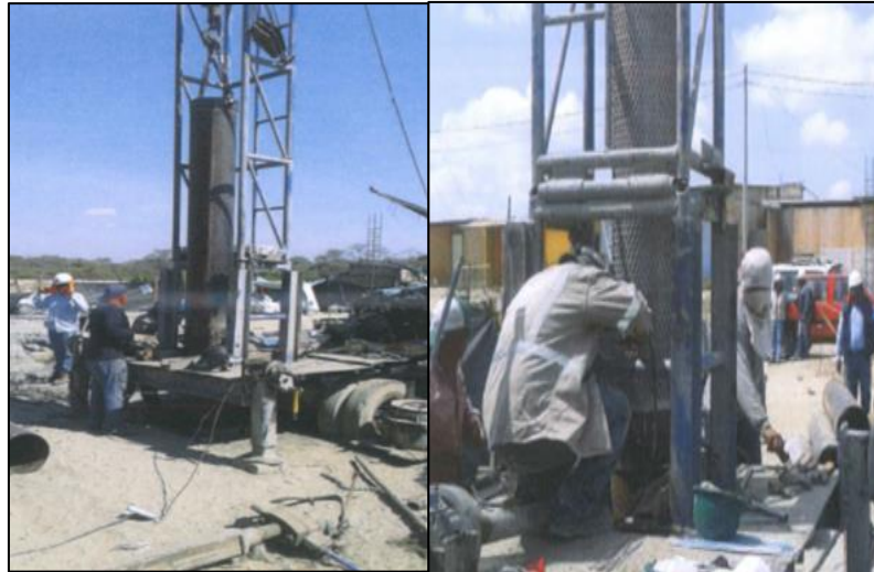
Figura 15. Colocación de tubería Ciega y tubería de Filtro
