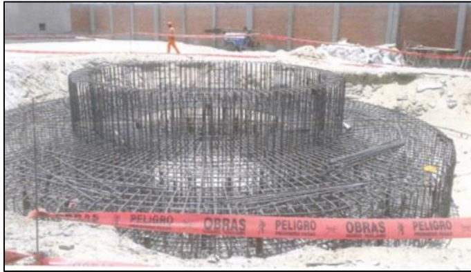
Figura 27. Acero Losa y Viga de Cimentación
