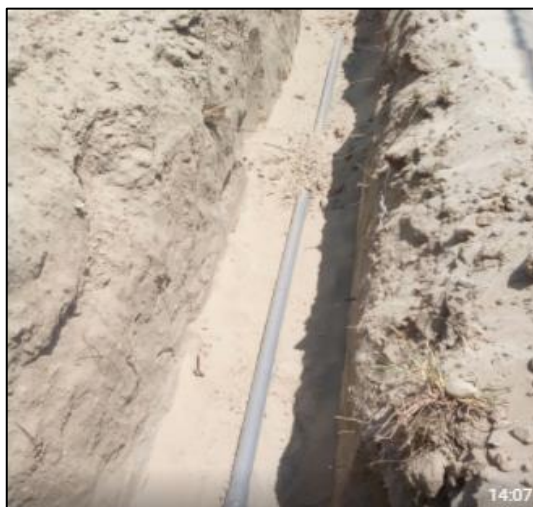
Figura 37. Instalación de Tubería PVC
