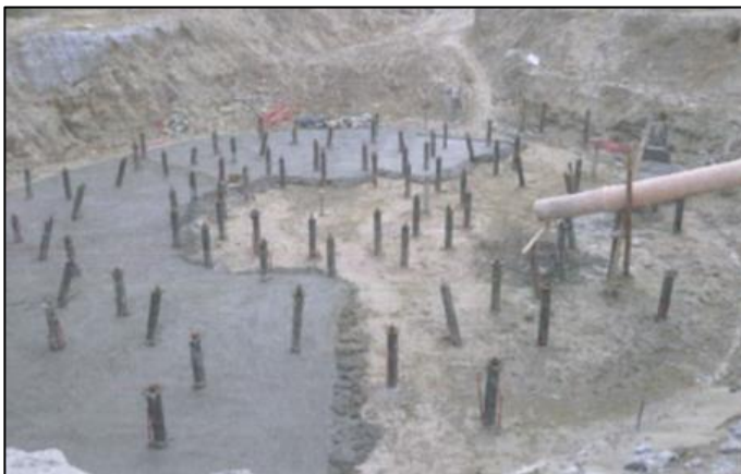
Figura 26. Vaciado de Solado
