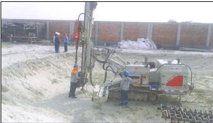
Figura 25. Instalación de Micropilotes
