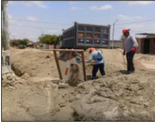
Figura 38. Preparando Material cama de arena
