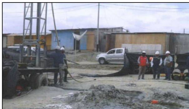
Figura 14. Trabajo de Rimado de \varnothing 8" a 25" y \varnothing 8" a 20"
