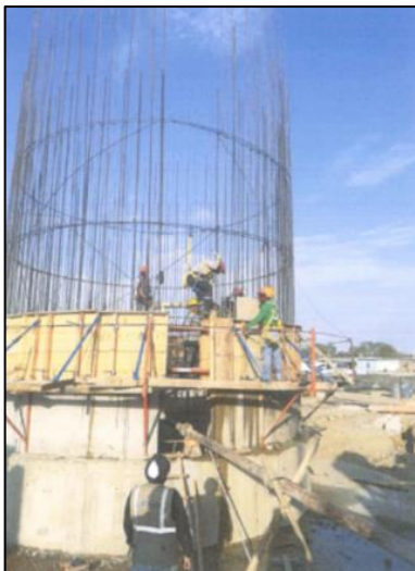
Figura 29. Encofrado fuste N° 03
