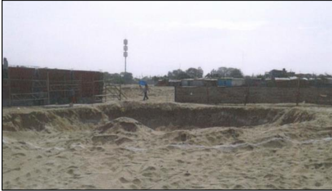
Figura 24. Excavación Cimentación de REP
