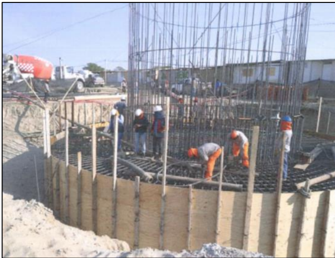
Figura 28. Vaciado de Concreto Viga de Cimentación
