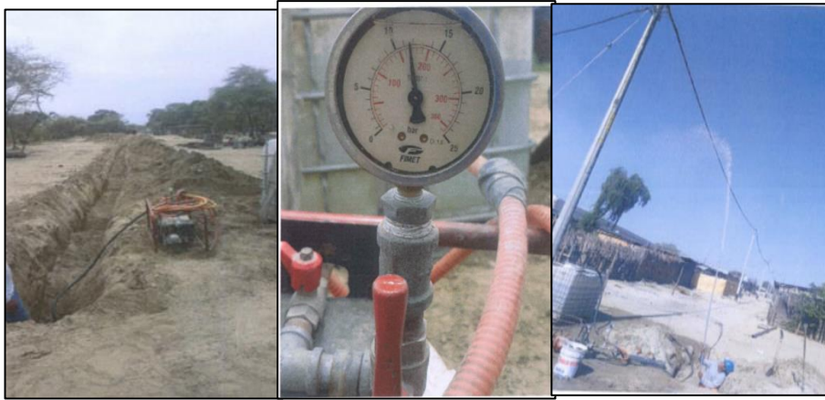
Figura 41. Prueba Hidráulica Redes
