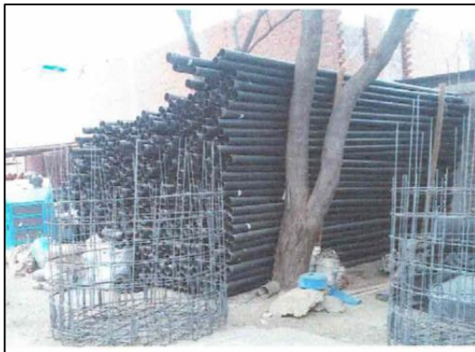
Figura 36. Suministro de Tubería PVC
