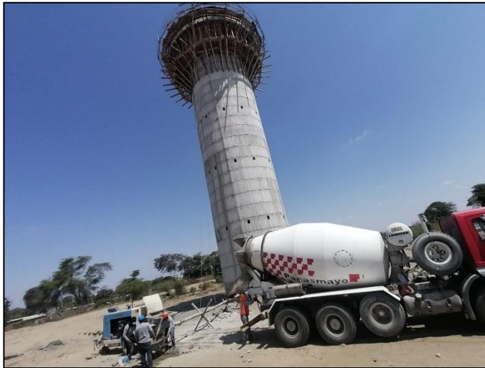
Figura 30. Encofrado Cúpula
