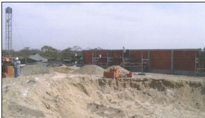
Figura 23. Construcción de Cerco Perimétrico
