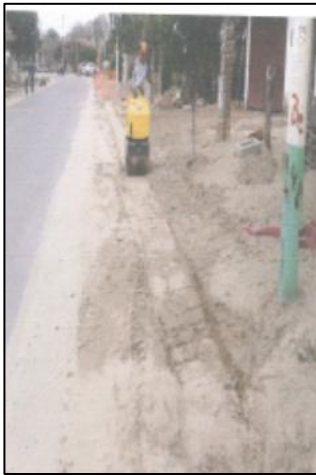
Figura 42. Trabajos de Compactación de zanja
