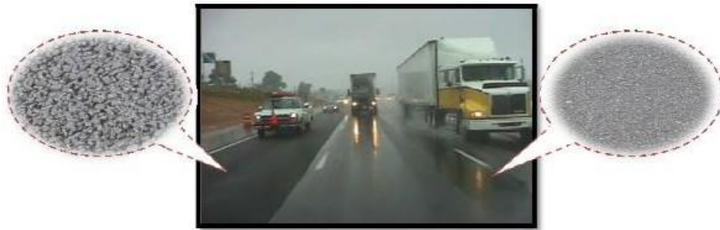
Figura 6. Carril externo con mezcla de graduación abierta (P. flexible) vs carriles centrales con mezcla convencional (Rígido).
