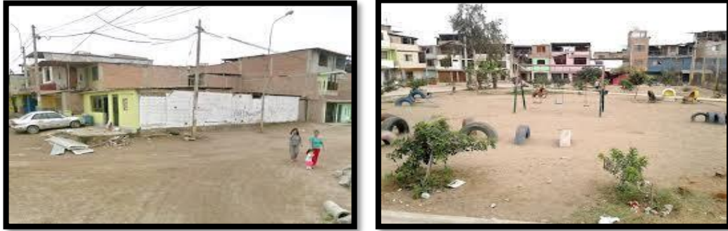
Figura 3: Falta de pavimentación.
