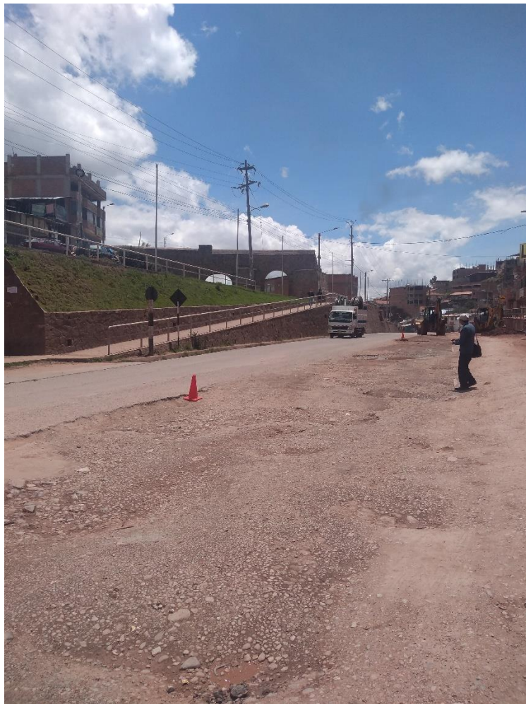
Anexo 7: Señalización del área de estudio.
