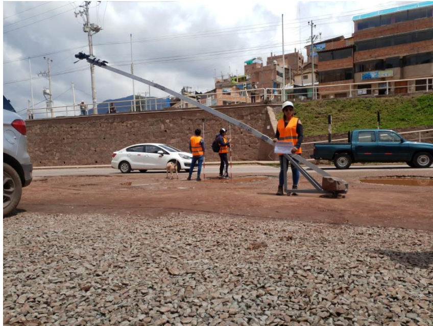
Figura 21. Izamiento y ubicación del carrito
