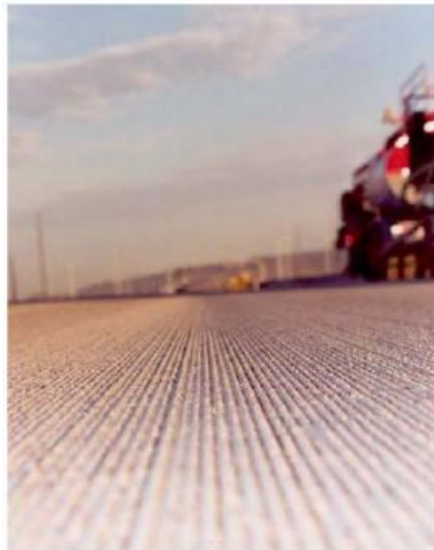
Figura 20. Pavimento rígido con textura realizada con Discos Diamantados
