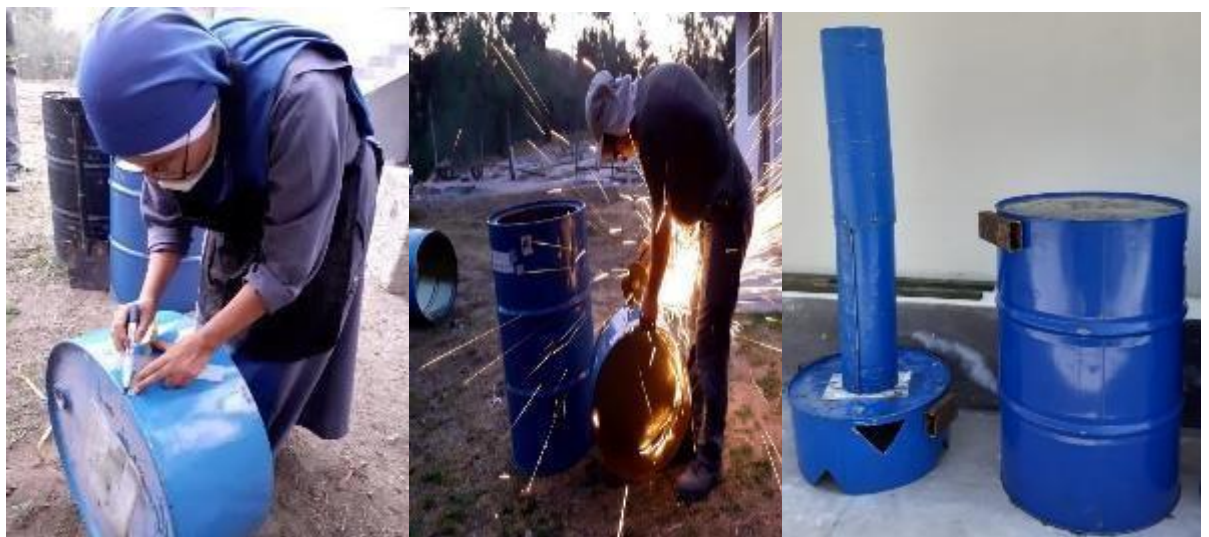
Figura 4 Construcción del horno
