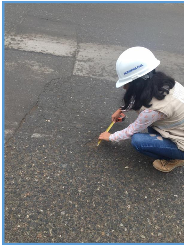
Fg 2. Medición de hueco.
