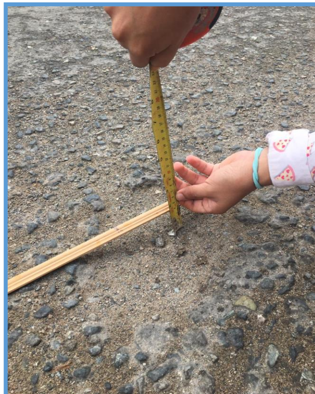
Fg 5. Medición del diámetro bache o hueco.
