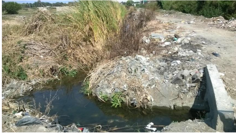
Figura 4: Crecimiento de vegetación y residuos por falta de descolmatación de canales y arroyos.
