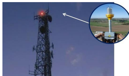
Figura 10 Señalización en la parte superior de la torre de telecomunicaciones
