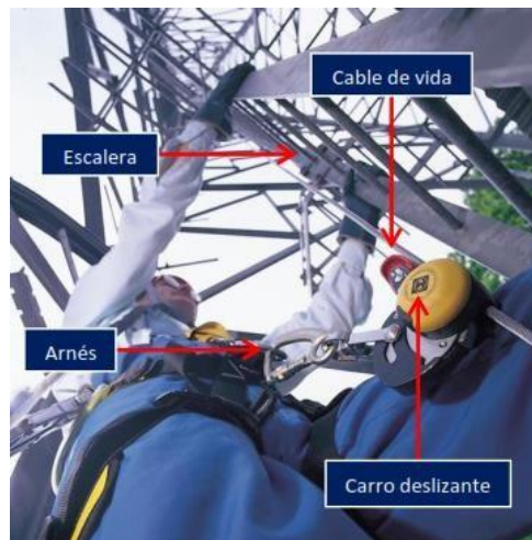
Figura 6 Elementos de seguridad para manipular una torre de telecomunicaciones
