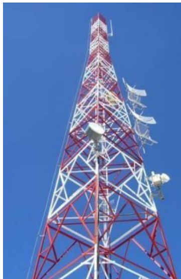
Figura 4 Estructura principal de una torre autosoportada
