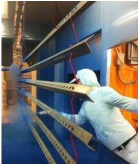
Figura 13 Galvanización de los elementos estructurales
