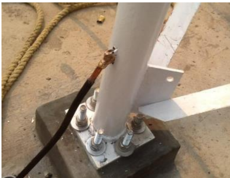
Figura 12 Conexión de red de tierras
