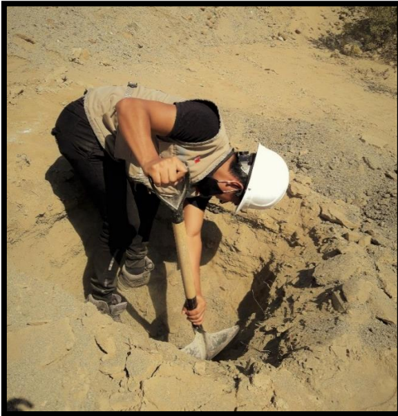
Figura N°5: Excavación de la primera calicata
