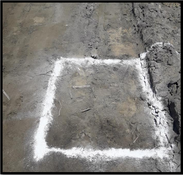
Figura N°6: Excavación de la segunda calicata
