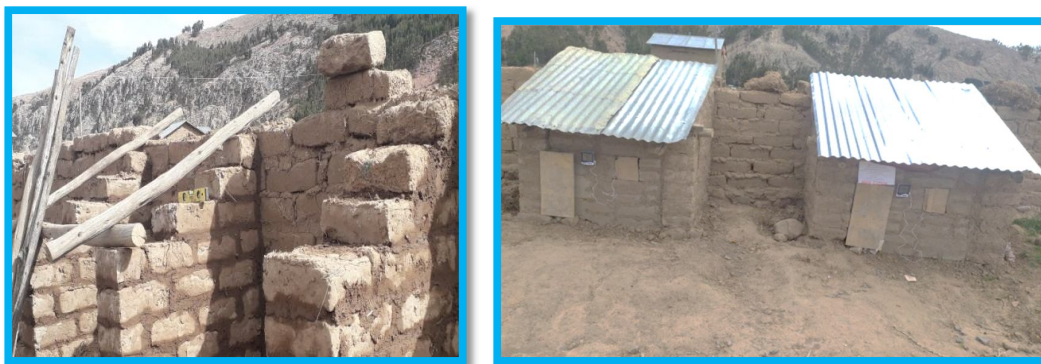
Figura 46 Construcción de las viviendas de 1m x 1m y registro de las temperaturas.
