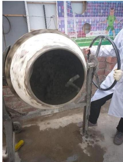
**Figura 40.** Proceso de mezcla de concreto  $f'c = 210$  kg/cm<sup>2</sup>
