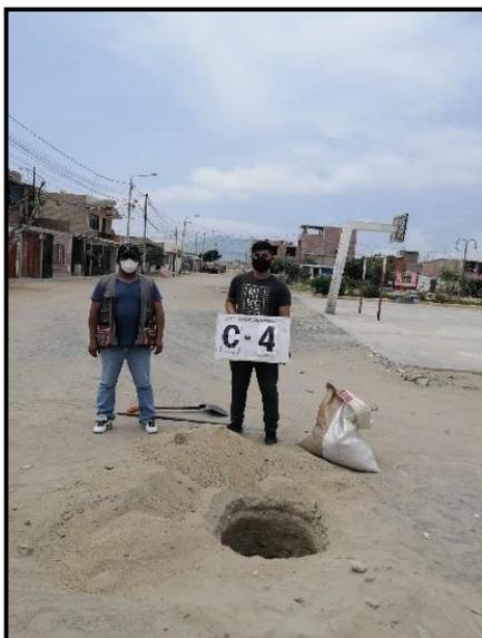
**Fotografía N°08:** Excavación de la calicata C – 4 con profundidad de 1.50m. en el A.H. Villa Hermosa en la intersección de la calle N°1 y calle N° 8
