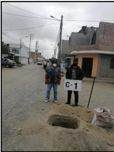
**Fotografía N°06:** Excavación de la calicata C – 1 con profundidad de 1.50m. en el A.H. Villa Hermosa en la Calle N° 1
